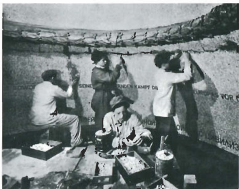
Отделочные работы внутри постамента памятника
