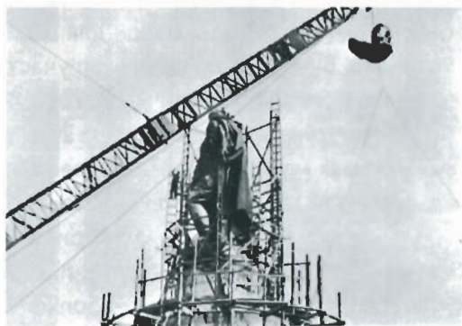
Завершающий этап строительства памятника
