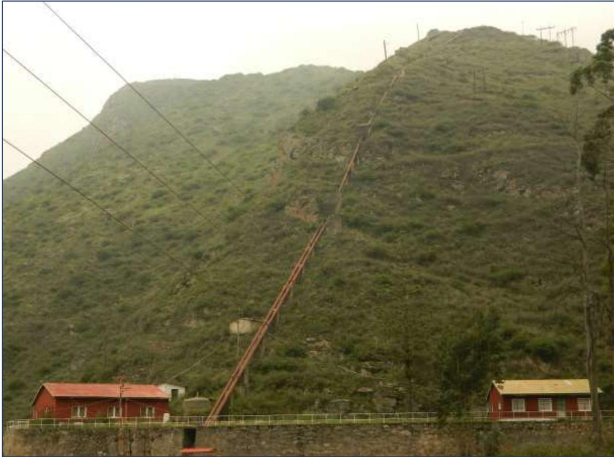
FIGURA 3. 14: DETALLES DE LA TUBERIA FORZADA DE TINGO – VISTA TRANSVERSAL
