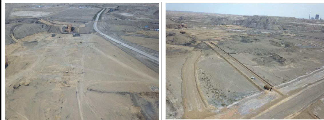
帐篷沟煤矿拆除后的工业场地
