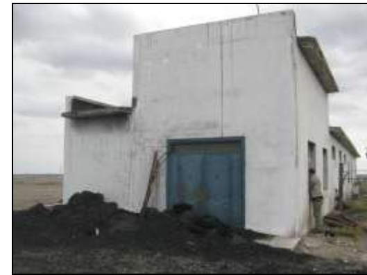
原天隆矿临时锅炉房
