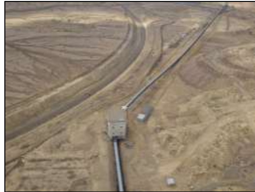
依托输煤廊道
