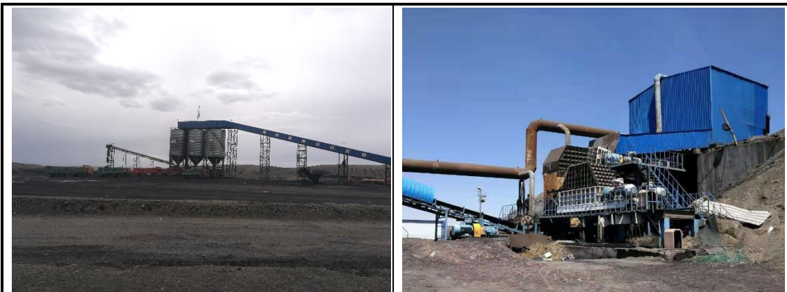
帐篷沟煤矿拆除前的工业场地
