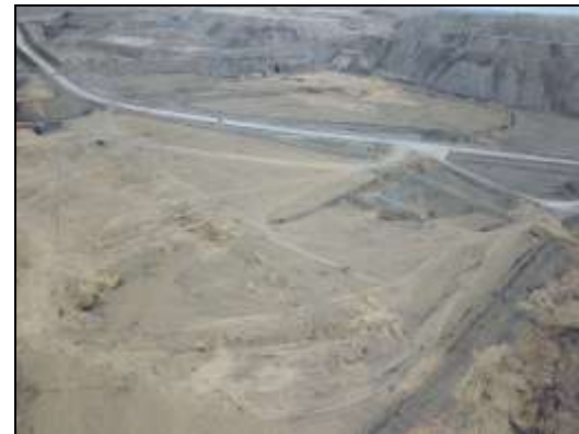
原大成煤矿工业场地及外排土场
