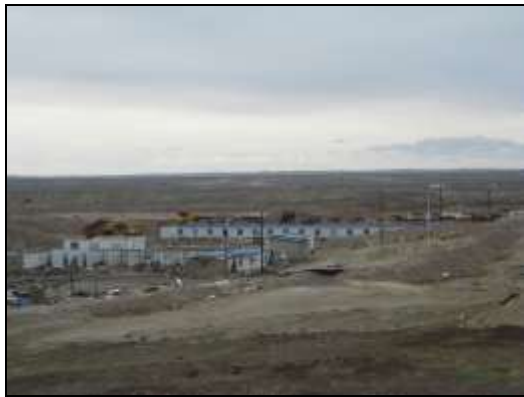
原天隆矿临时施工营地
