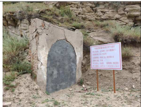
图 4-2-2 已封闭废弃井筒
