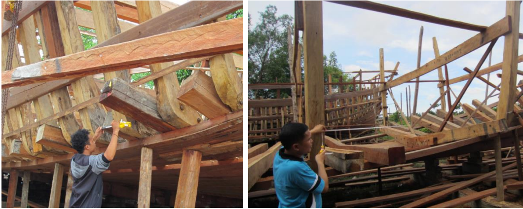
Gambar 1. Pengukuran besar wrang
