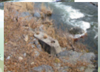
森林軌道の橋脚跡
