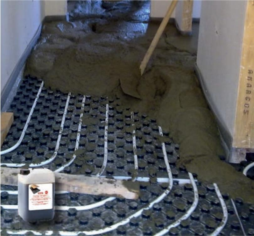
El espesor de la placa-mortero debe calcularse de acuerdo a las normas pertinentes y teniendo en cuenta la capacidad de carga y la fuerza de flexión. El grosor de mortero por encima de los tubos debe ser como mínimo de 30-40 mm sobre la generatriz superior del tubo, no aceptándose variaciones mayores a 1 cm (la base debe estar nivelada con anterioridad a la colocación del aislante).
