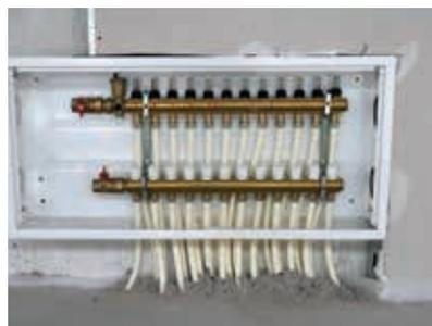
El número de vías del colector se corresponderá con el número de circuitos conectados. El número de colectores requeridos por planta dependerá del número máximo de circuitos por colector y de la distribución de la planta. El colector distribuirá agua a los circuitos conectados al mismo con la temperatura de impulsión de todos a todos ellos.
