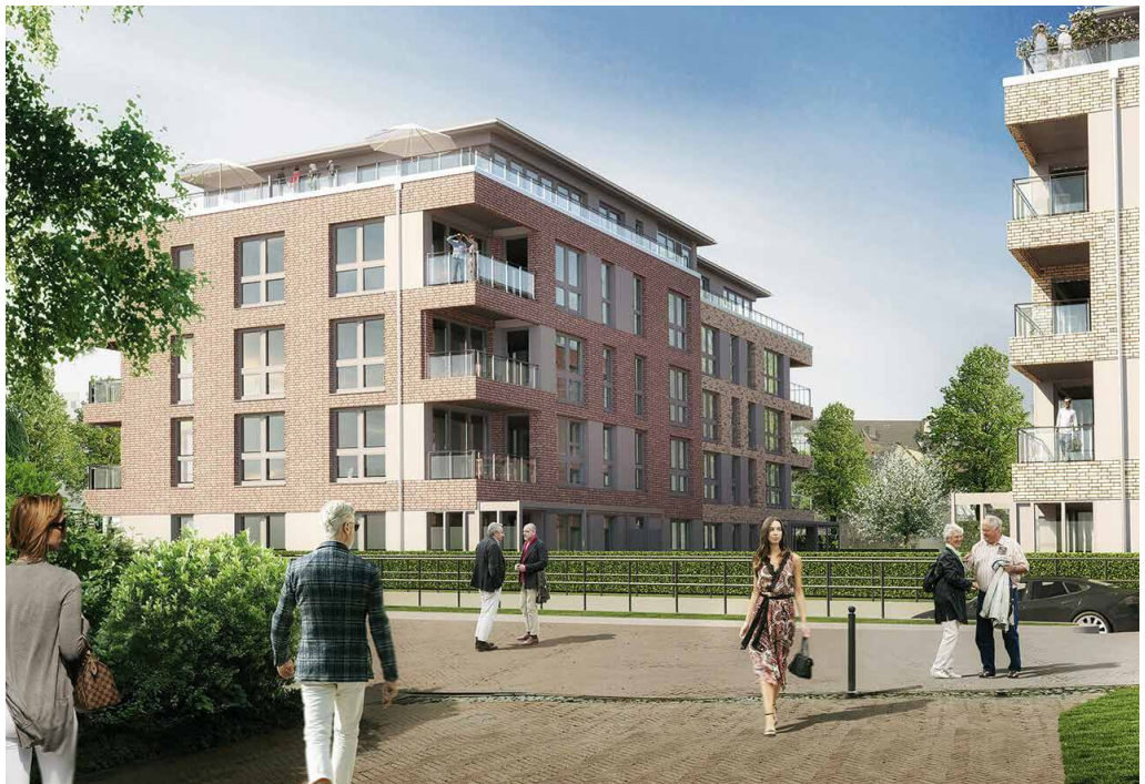
Mit dem Stadtplatz-Carré hat die Kreissparkasse Walsrode ein weiteres Gebäude errichtet, das den örtlichen Wohnungsmarkt entlastet.
