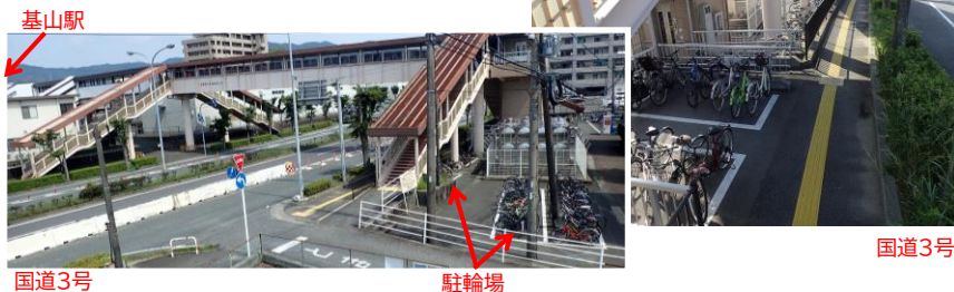
写真 駐輪場の整備状況
