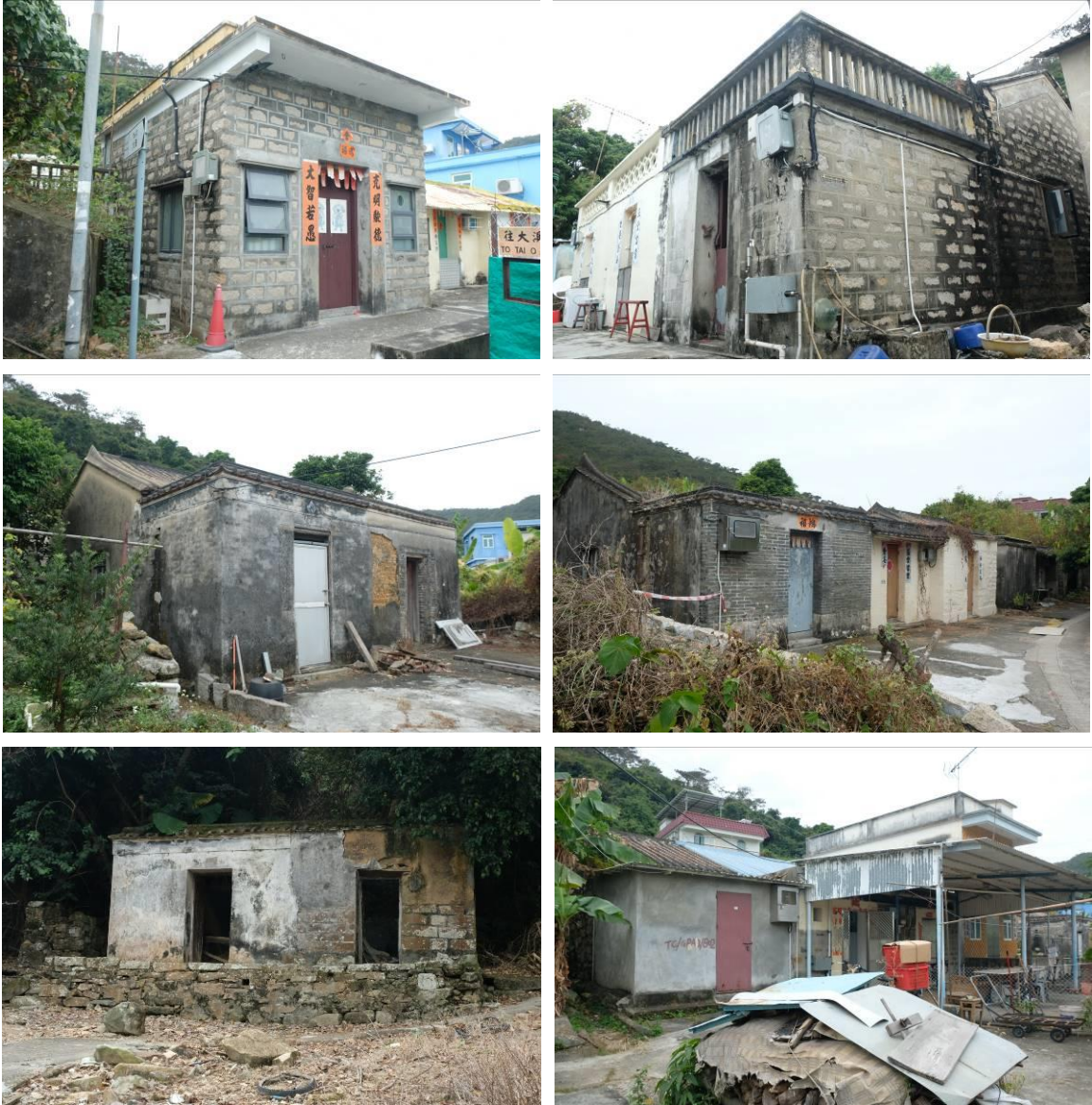
圖 52. 以石砌成的村屋（上）；以青磚及夯土建成的村屋（中）；破爛的村屋及經歷改動的村屋（下）
