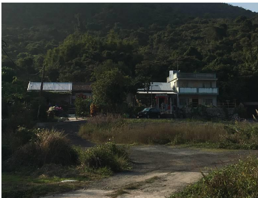
圖 49. 藍峯村一排的村屋，大致上仍保存有中式金字塔型屋頂的村屋模樣。
