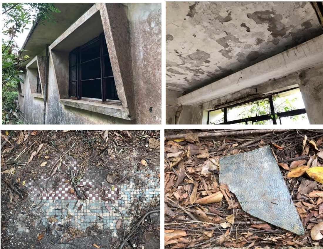
圖 110. 礦場辦公室設計細節：窗戶的斜框緣（左上）；燈槽（右上）；紙皮石鋪地（左下）；壓花玻璃（右下）。
