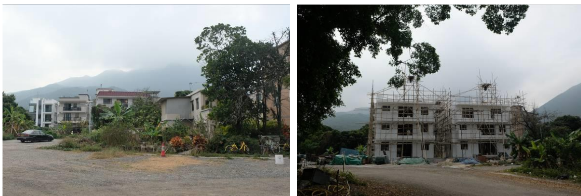
圖 46. 石榴埔村新建的房屋。
