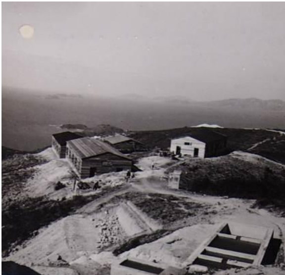
圖 103. 第十二號持牌人建設的清水池、宿舍和 辦公室。（攝於1952年） 391
