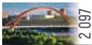
Бугринский мост через Обь, Новосибирск (2014)
