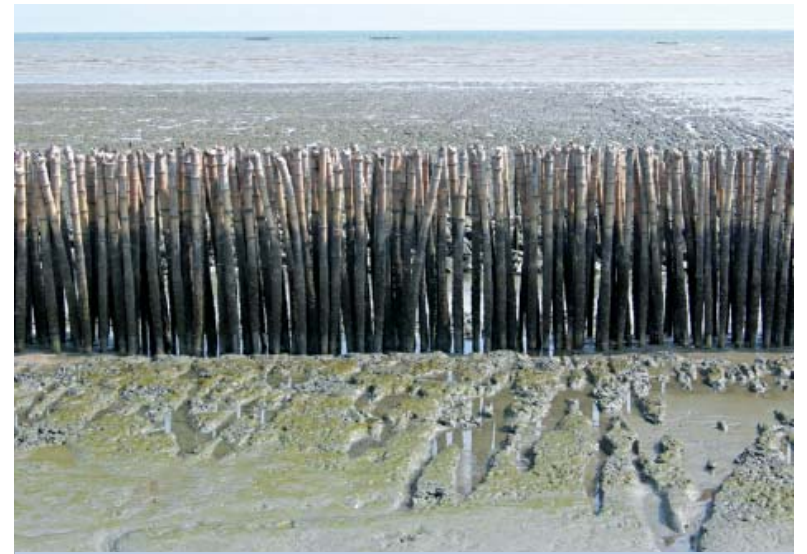
ตะกอนดินเลนที่ถูกน้ำทะเลพัดมาทับถมหลังแนวเขื่อนไม้ไผ่
