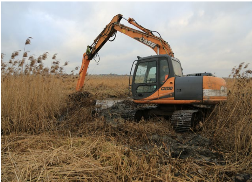
Ryc. 21.4 Uaktywnianie zarastających koryt rzecznych (fot. A. Bielonko)
