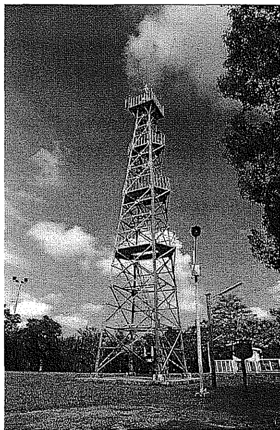
▲因為受到鄰近校舍的影響原本的風力塔已無法準確的測候故另建一測候鐵塔以茲觀測
