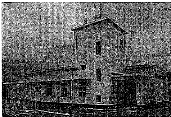
▲蘭嶼氣象站正門現況
