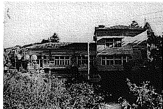
▲民國71年拆除西側二層樓(陳福來先生提供)
