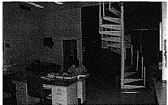
▲作業室的旋轉樓梯是通往屋突上的風力鐵塔
