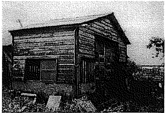
▲木造雨淋版氫氣房(中央氣象局提供)
