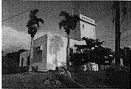
▲成功氣象站現況
