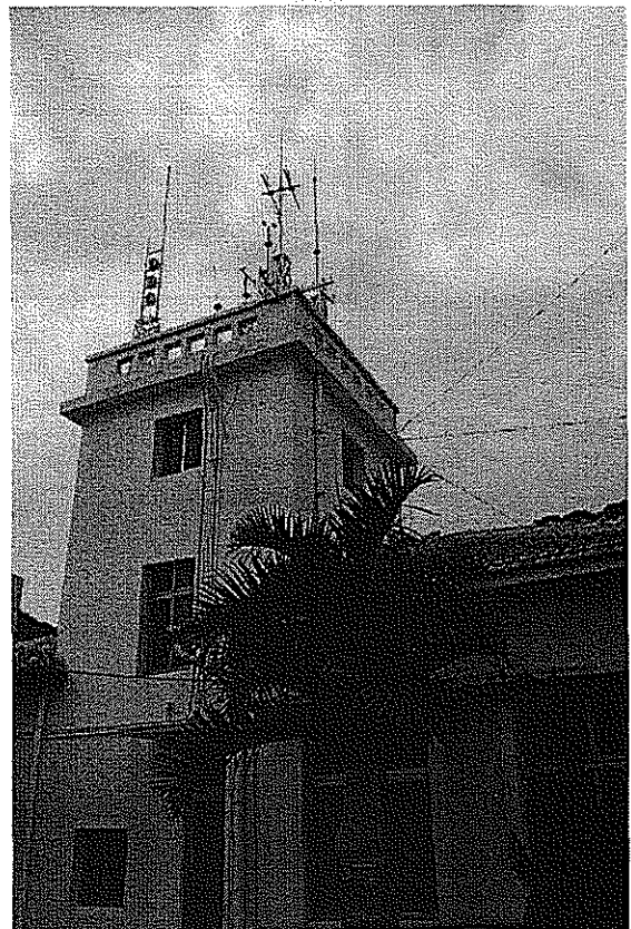
▲大武氣象站風力塔
