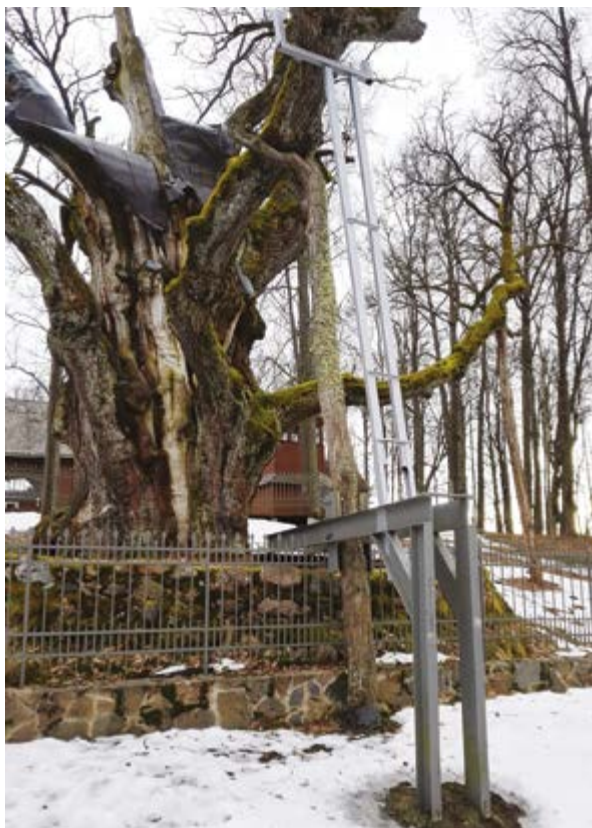
197 pav. Metalinė Stelmužės ąžuolo šakos atrama (Zarasų r.)
