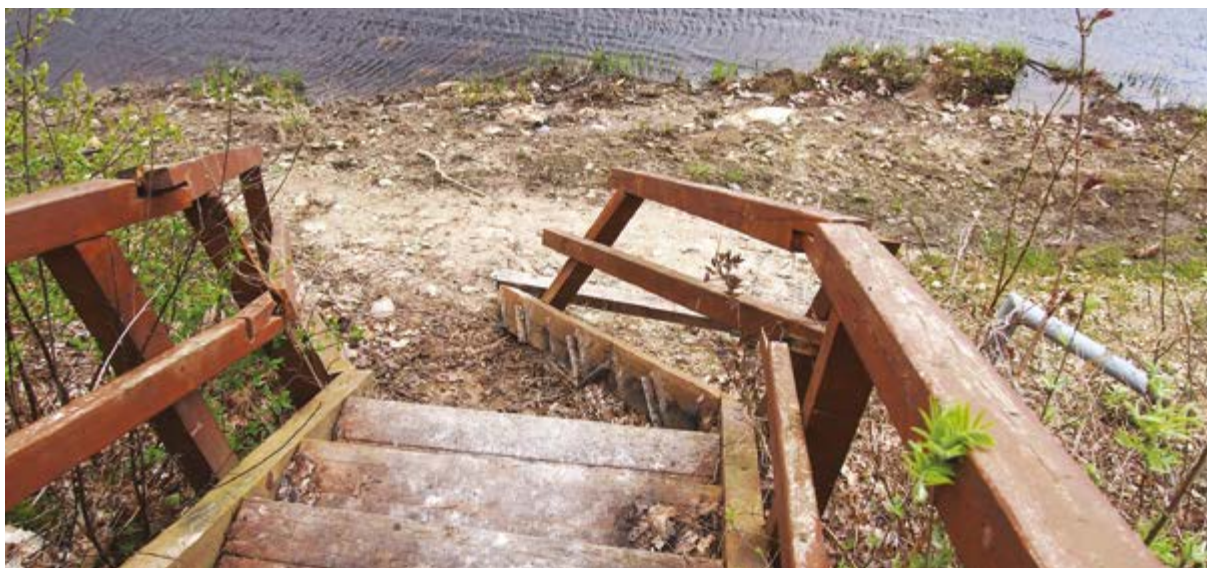
116 pav. Apatinė laiptų dalis turi būti atspari ledonešiu ir nuleista ne per žemai (arba atlenkiama ir sezoniškai aptarnaujama)
