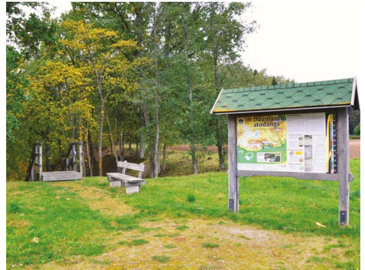
96 pav. Iš natūralių ir jas imituojančių medžiagų pagamintas stendas. Apsaugant nuo drėgmės įsigėrimo, medinė konstrukcija neįkasta į gruntą, todėl su juo nėra tiesioginio sąlyčio.
