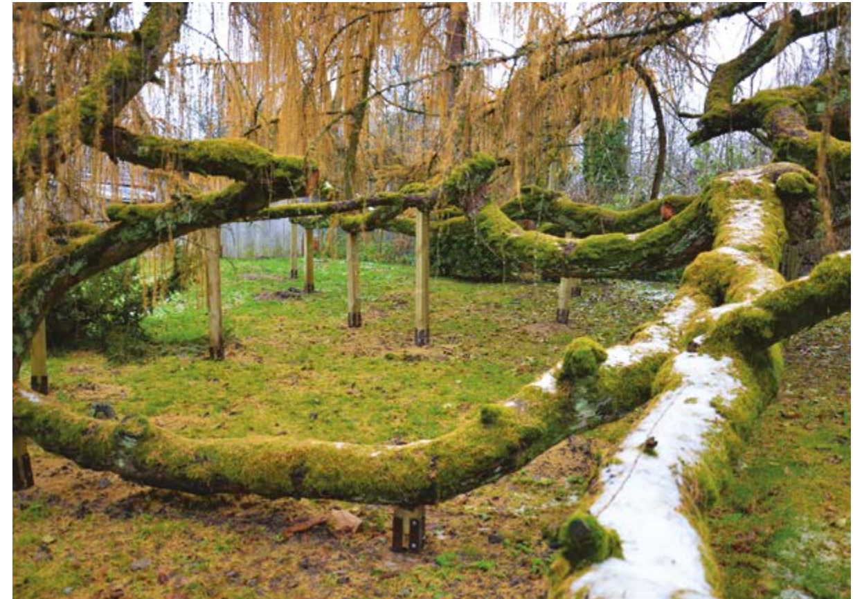
195 pav. Medinės atramos, įrengtos 2016 m. tvarkant Dabulevičių maumedį (Vilkaviškio r.)
