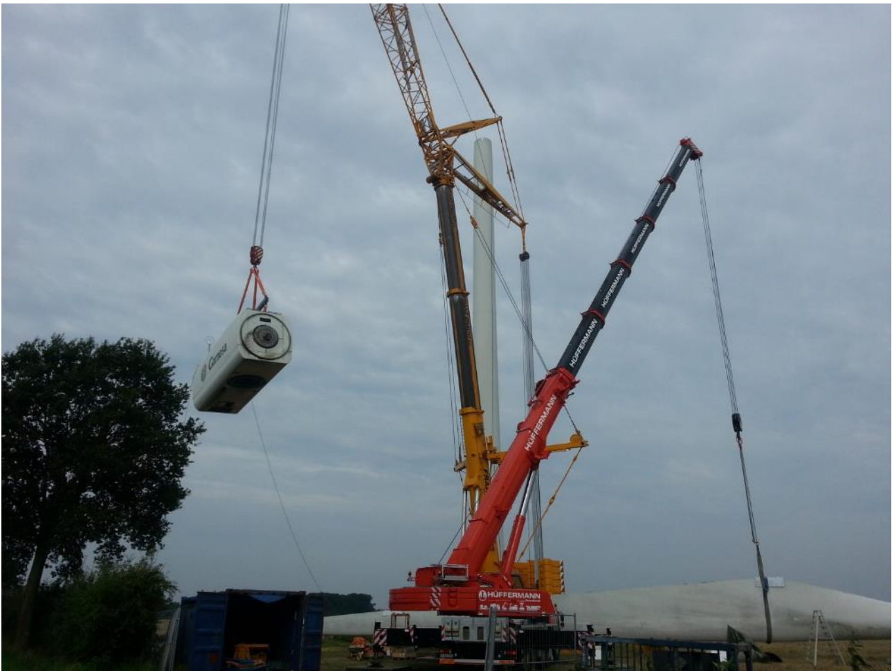
Abbildung 4: Rückbau der Gondel
