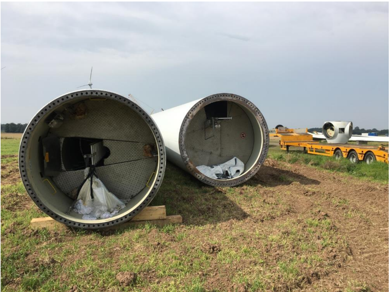
Abbildung 6: Gegen Wegrollen gesicherte Turmsection
