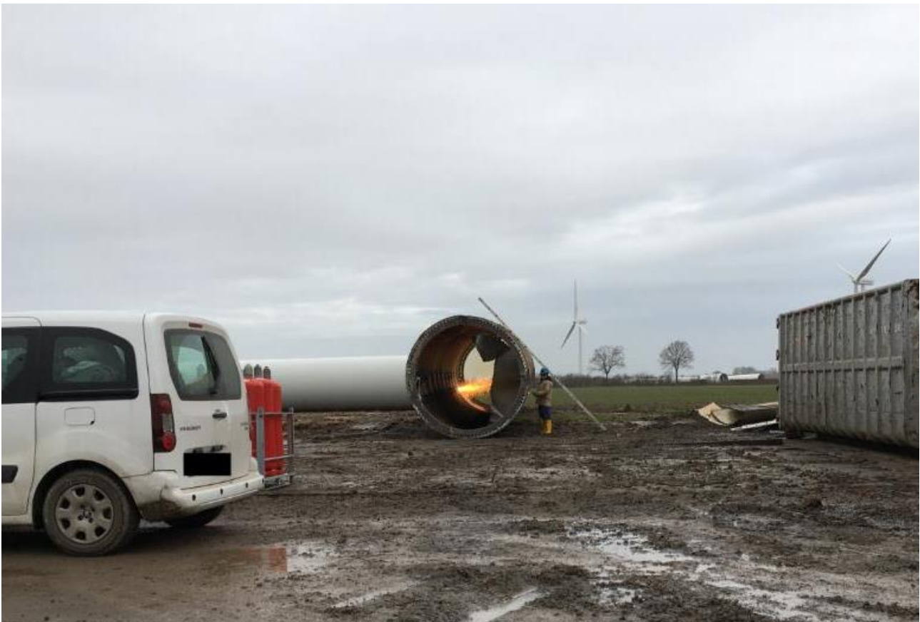
Abbildung 5: Zerlegung einer Turmsektion
