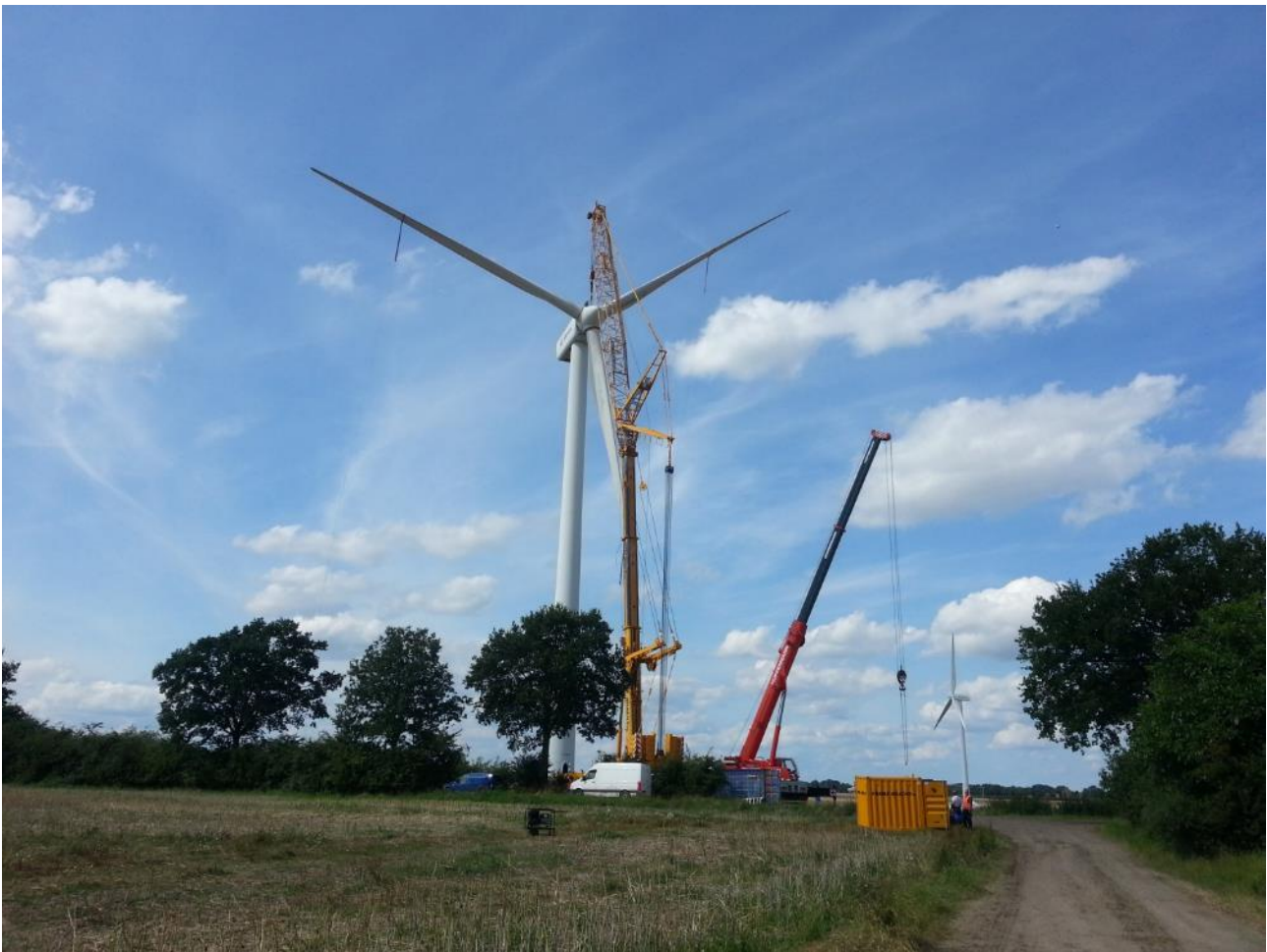
Abbildung 2: Darstellung eines Hauptkrans in Gelb und eines Hilfskrans in Rot
