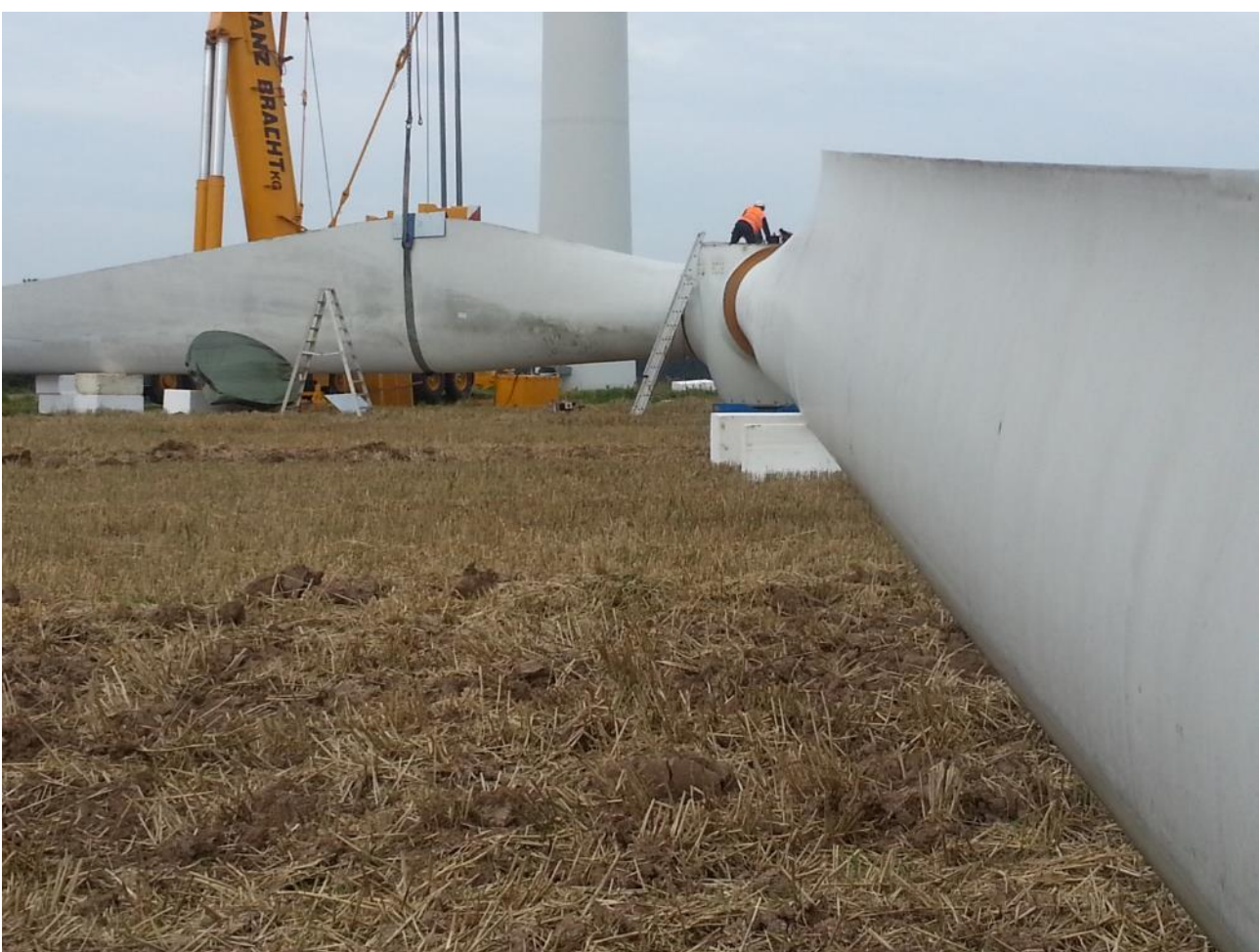
Abbildung 3: Demontage des Rotorsterns am Boden
