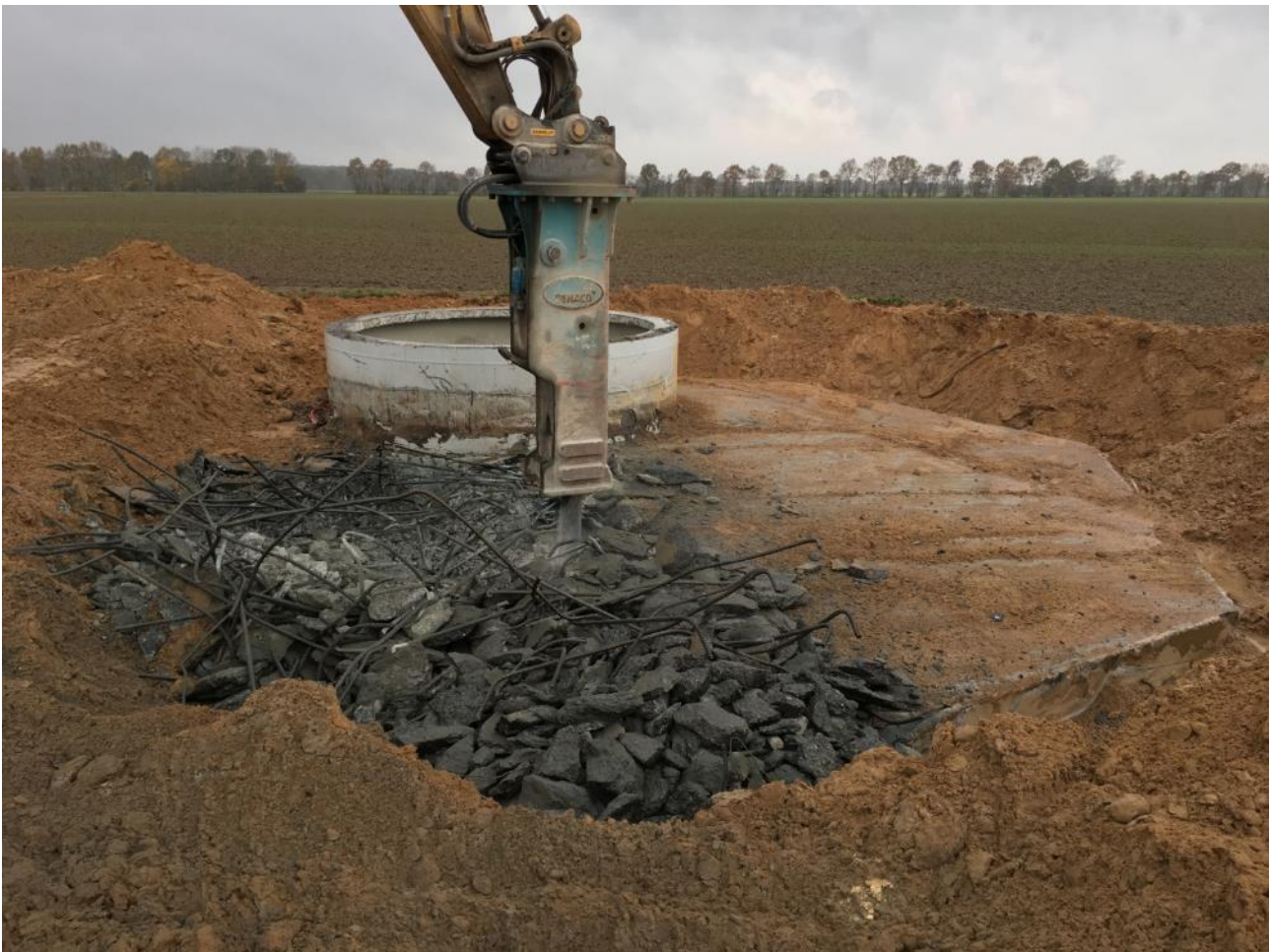
Abbildung 7: Fundamentrückbau mittels Bagger
