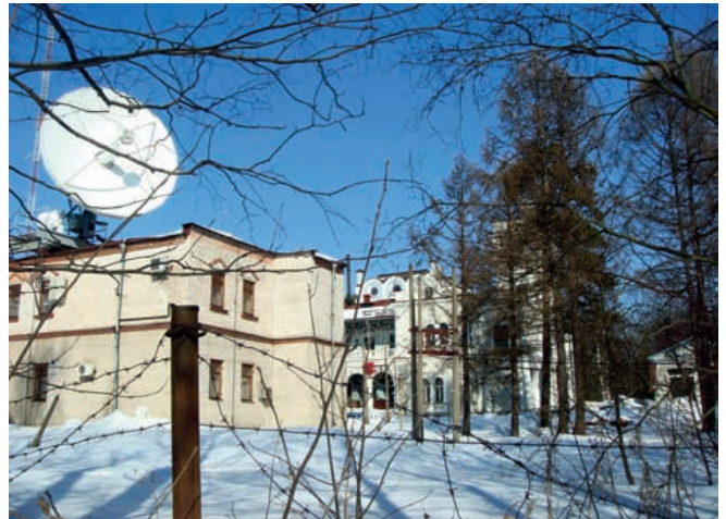
121. «Белый замок» В.А. Стенбок-Фермора за колючей проволокой, отрезанный от моря зданием, возведенным в 1990-х гг (025h). 2011
