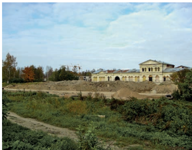
113. Михайловка. Конюшенный корпус в ходе реконструкции (015). 2010
