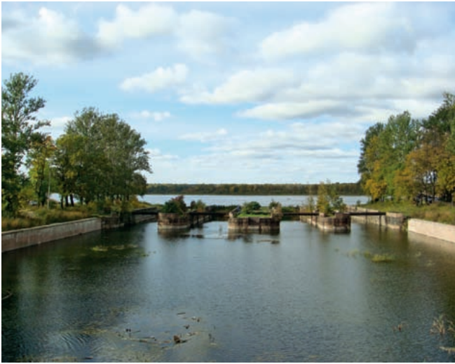
73. Шлюз Староладожского канала в Шлиссельбурге (004а). 2010
