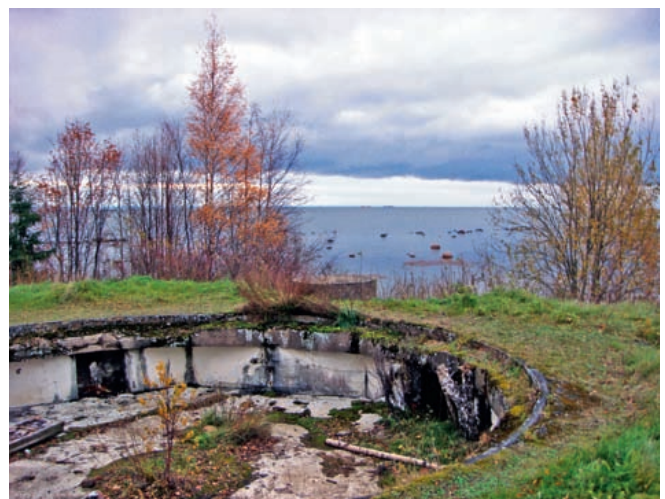
99. Орудийный барбет и ДОТ западной батареи форта Серая Лошадь (003c3). 2010
