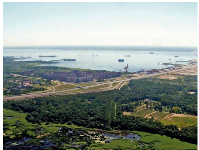
98. Дамба, пересекающая остров Котлин. 2010. Фото: vulkan-avia. http://fotki.yandex.ru
