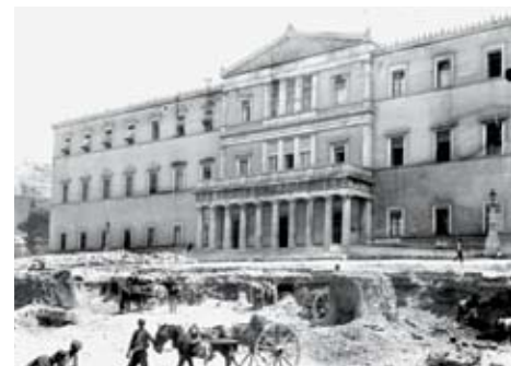
Εργασίες κατασκευής του Μνημείου του Αγνώστου Στρατιώτη
