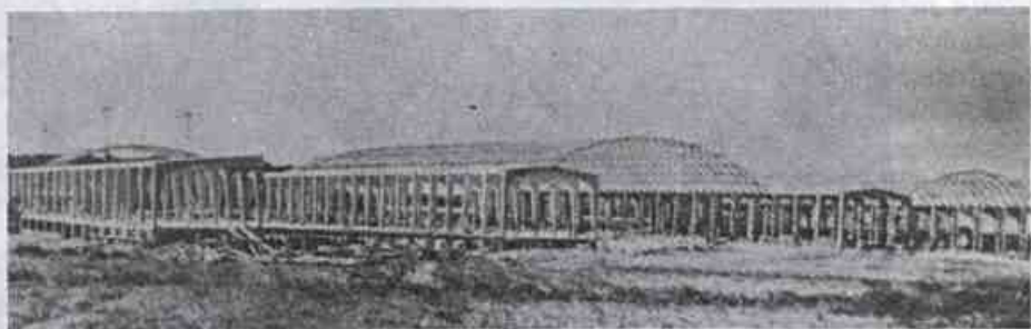
Estruturas das Oficinas prontas
