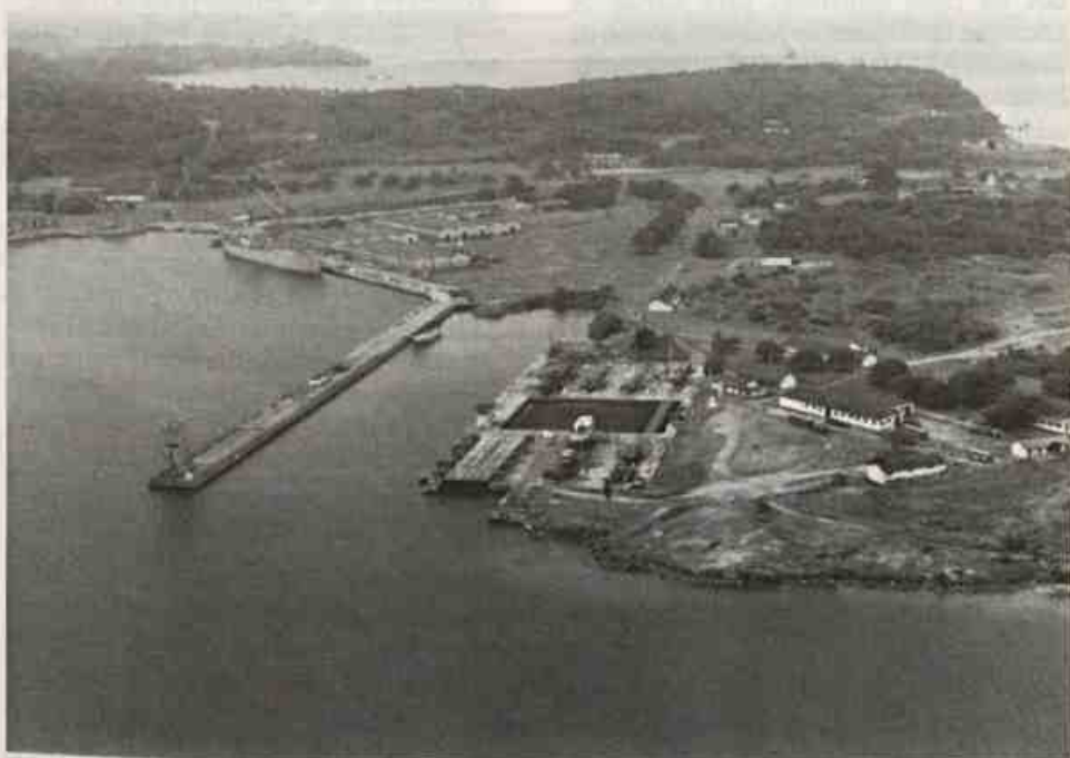
O pier e o Sistema do Elevador de Navios
