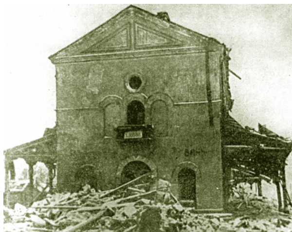
207. Разрушенный вокзал в Любани. 1944 г.
