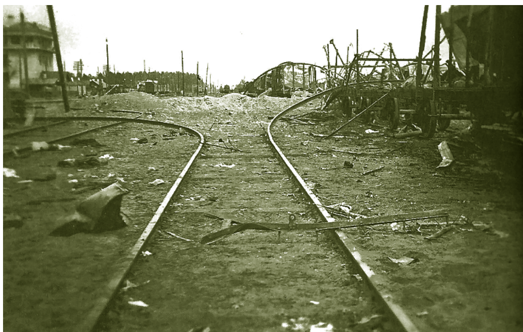
20. Разрушенная станция Мга. 1941 г. Коллекция Д. Жукова
