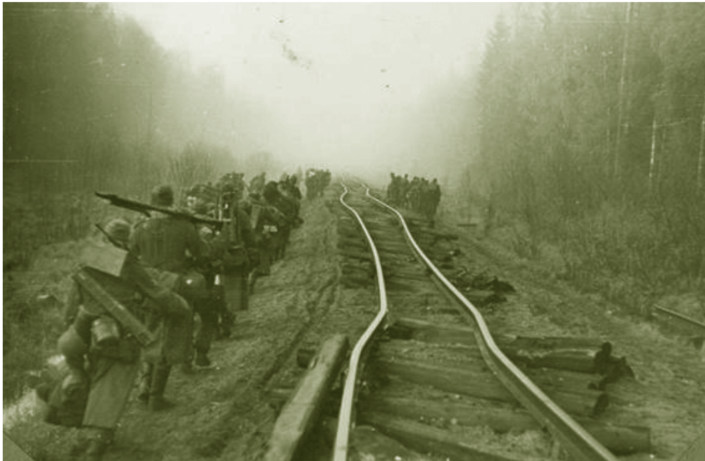
123. Разрушенная дорога на Радофинниково
