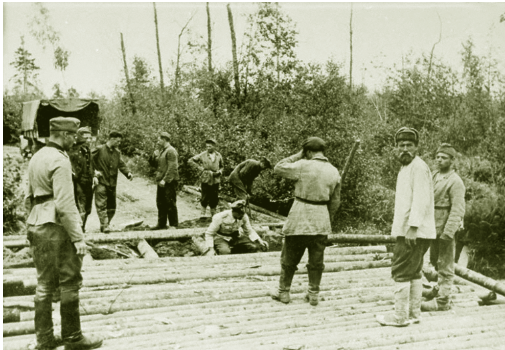
66. Строительство гати (настила через болотистый участок) силами местных жителей и военнопленных
