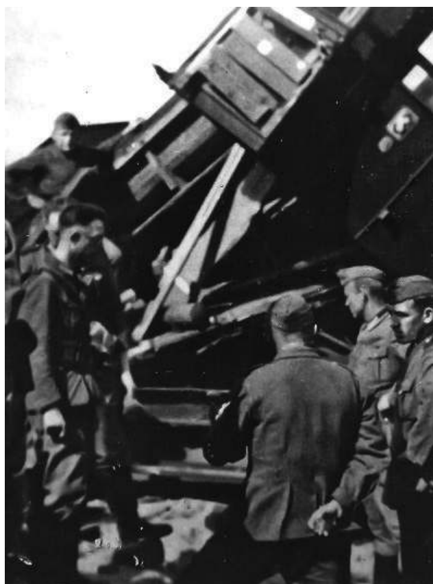
124. Подорванный эшелон. Ленинградская область
