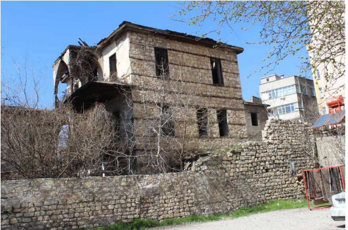
Fotoğraf 4 Aytemiz Evi Doğu Cephe Yığma Duvar Ayrıntı
