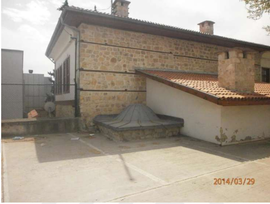
Fotoğraf 87 Mahmut Arif-i Paşa Konağı Kuzey Cephe Hamam Örtüsü
