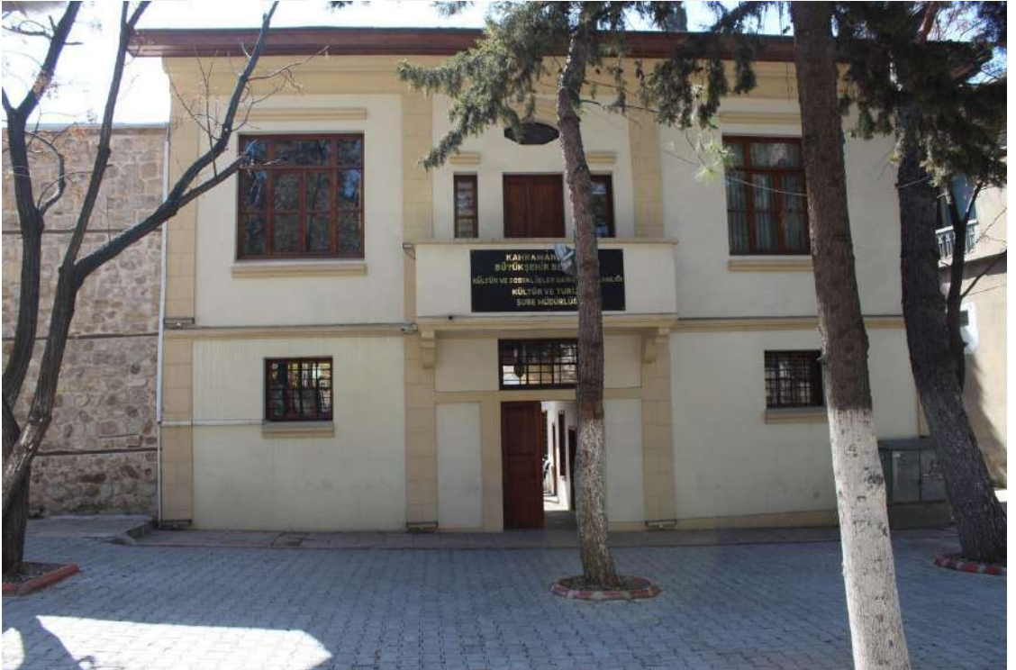
Fotoğraf 74 Köker Konağı Kuzey Giriş Cephesi
