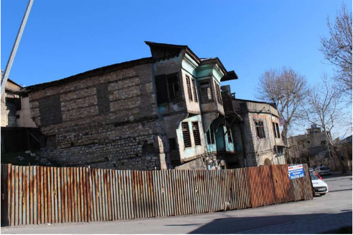
Fotoğraf 73 Kocabaşların Evi Kuzey Batı Cephe Görünüm
