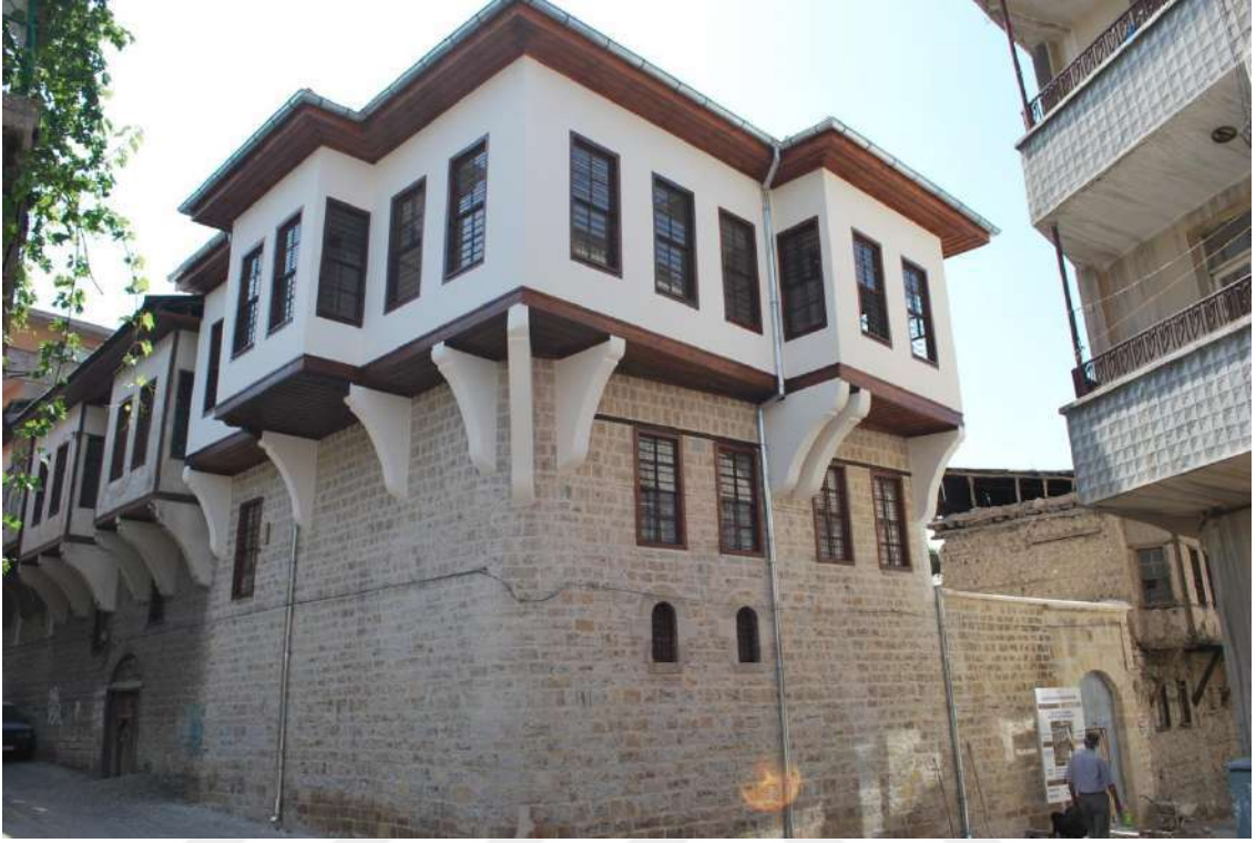
Fotoğraf 31 Dedeoğlu Konağı Batı Cephe Genel Görünüm
