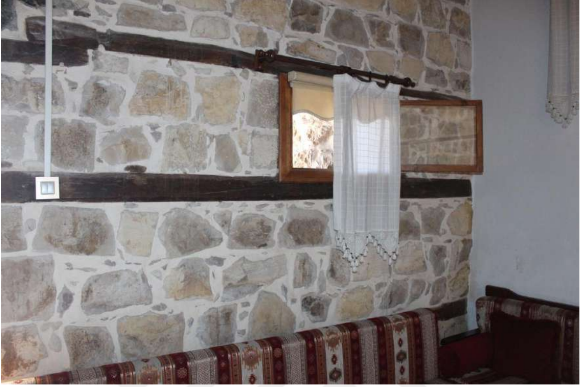
Fotoğraf 43 Deli Gönül Konağı Yığıma Taş Duvardan Ayrıntı
