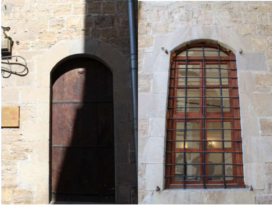
Fotoğraf 53 Eski Postahane Binası Kapı Ve Pencere Kanatları
