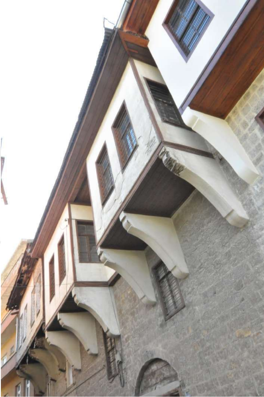
Fotoğraf 33 Dedeoğlu Konağı Batı Cephe Genel Görünüm
