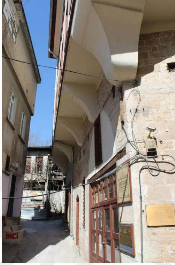
Fotoğraf 52 Eski Postahane Binası Zabunlar konağı Cephe Taşırmaları
