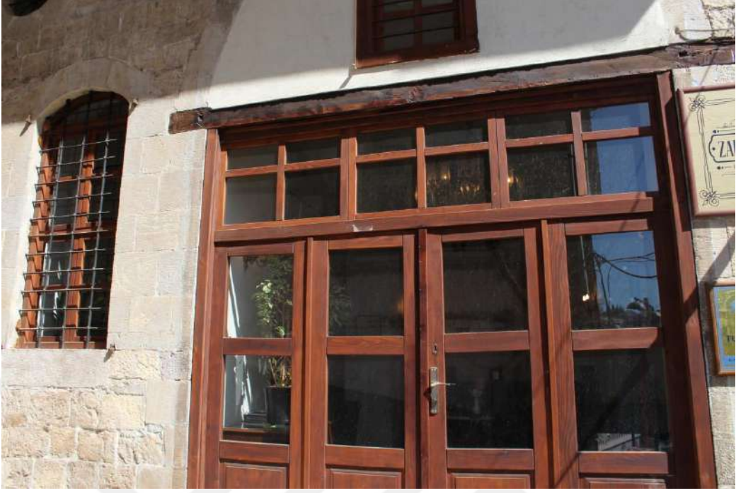
Fotoğraf 51 Eski Postahane Binası Aşağı Giriş Kapısı
