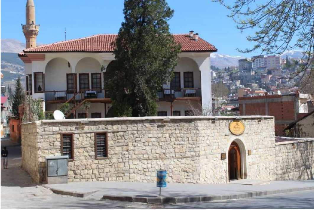
Fotoğraf 61 Kocabaşların Konağı Güney Cephe
