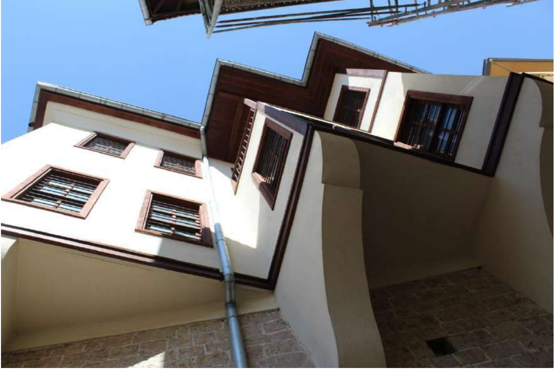
Fotoğraf 50 Eski Postahane Binası Zabunlar Konağı
