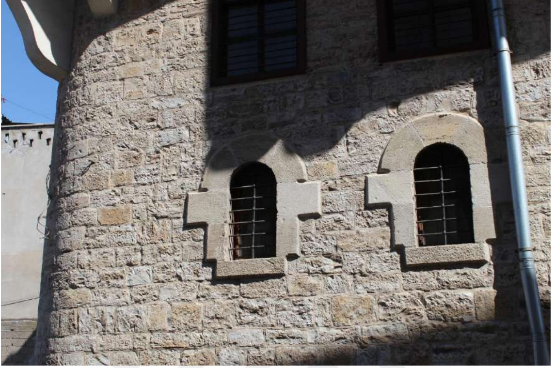
Fotoğraf 34 Dedeoğlu Konağı Zemin Kat Pencereleer
