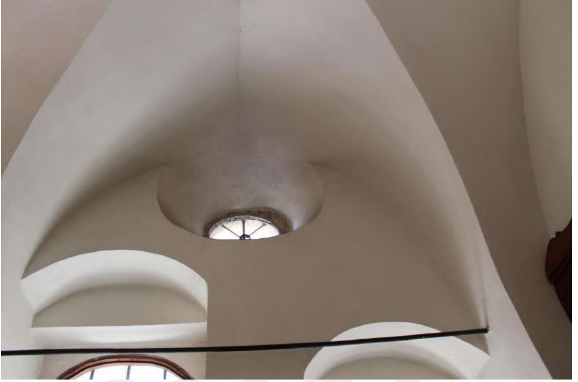
Fotoğraf 54 Eski Postahane Binası Çapraz Tonozlu Örtü Sistemi ve Daire Pencereleer
