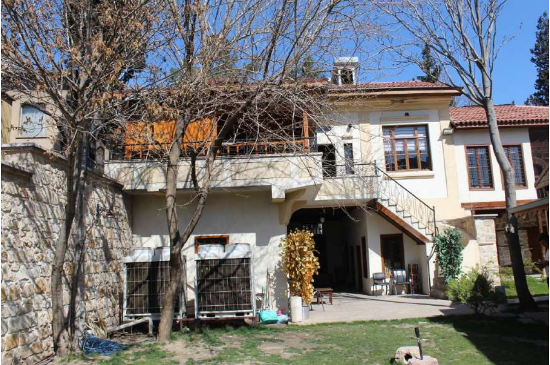
Fotoğraf 76 Köker Konağı Güney Avluya Bakan Cephesi
