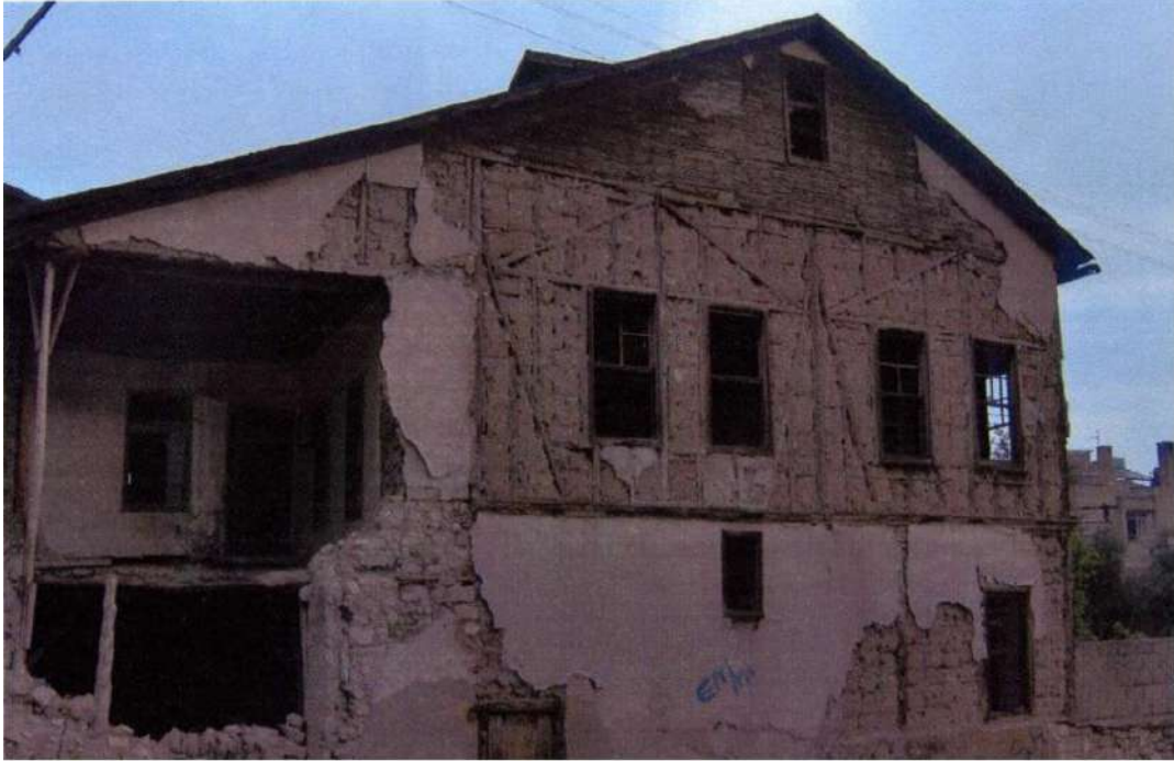
Fotoğraf 22 Çelebiler Evi Batı Cephesi
