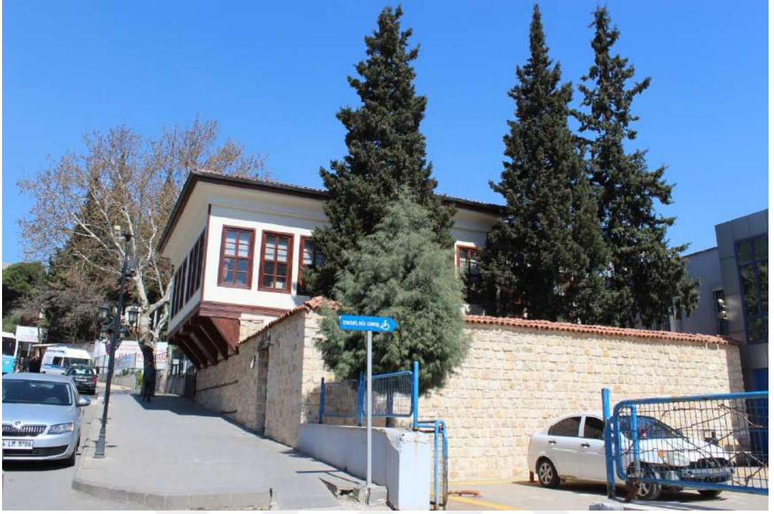
Fotoğraf 85 Mahmut Arif-i Paşa Konağı Güney Cephe Genel Görünüm
