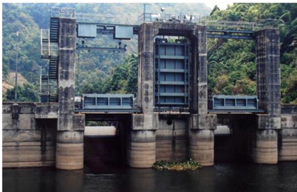
Gambar 6. Bendung pengendali Siruar, mengendalikan aliran keluar ( outflow ) dari Danau Toba ke Sungai Asahan, hingga Danau Toba tidak lagi berfungsi sepenuhnya sebagai danau alami (Foto: A. Nontji).
