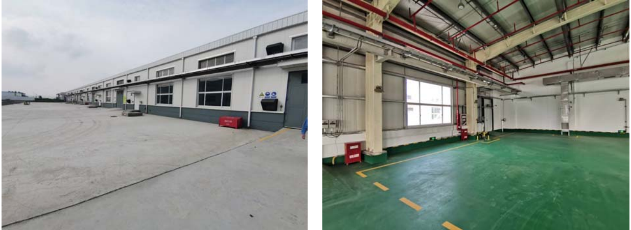
图 3.1.2.8-1 斯尔邦厂区现有危险废物仓库
