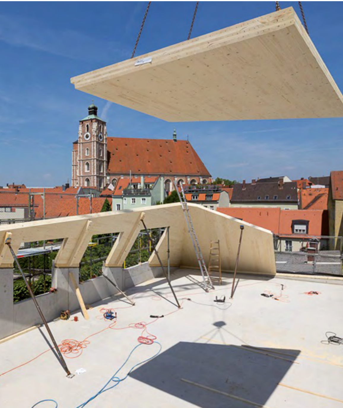
Erweiterungsbau des Medizinhistorischen Museums Ingolstadt: Das Dach wird zusammengefügt, 2015. Foto: Marcus Ebener, Berlin
