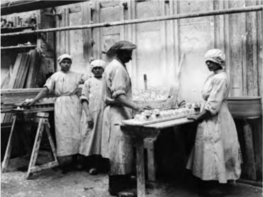
Op deze afdeling werden de producten in een glazuurbad gedompeld. Omstreeks 1920. Coll. SHCL
