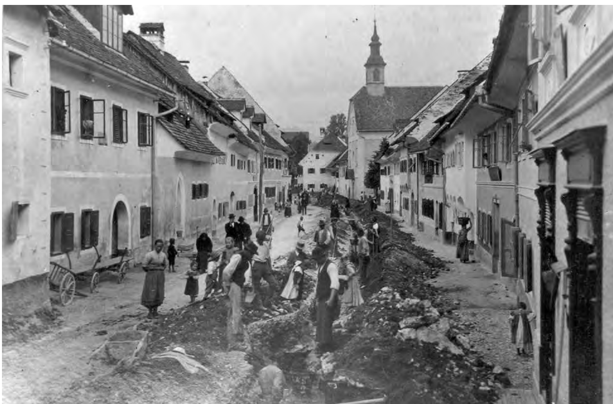
Kopanje jarka za napeljavo mestnega vodovoda na Spodnjem trgu v Škofji Loki leta 1902. (SI_ZAL_ŠKL/0279, Zbirka fotografij in razglednic, t. e. 12)
