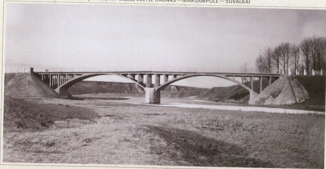
Gelžbetoninis tiltas per Šešupę Marijampolėje, Sankt Peterburgo—Varšuvos plente pastatytas 1926 m. Gelžbetoninis Kumelionių tiltas turi dvi trijų šarnyrų arkas, kurių anga po 25 m su viršskliautiniu statiniu iš kolonų ir briaunotosios plokštės. Tiltas 68,25 m ilgio. Šarnyrai paprasti — švininės plokštės.
