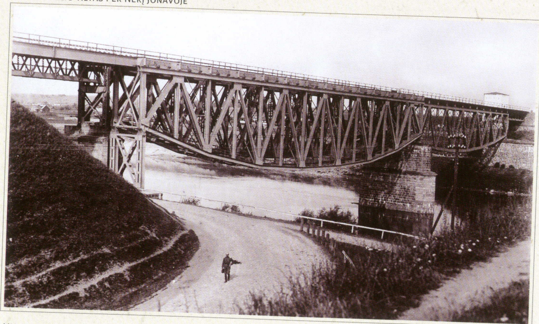
Vėliau buvo pastatytas keturių tarpatramių (21+2x75+21) metalinis tiltas. Tiltu ilgis 206 m; tiltu plotis 5,9 m.
