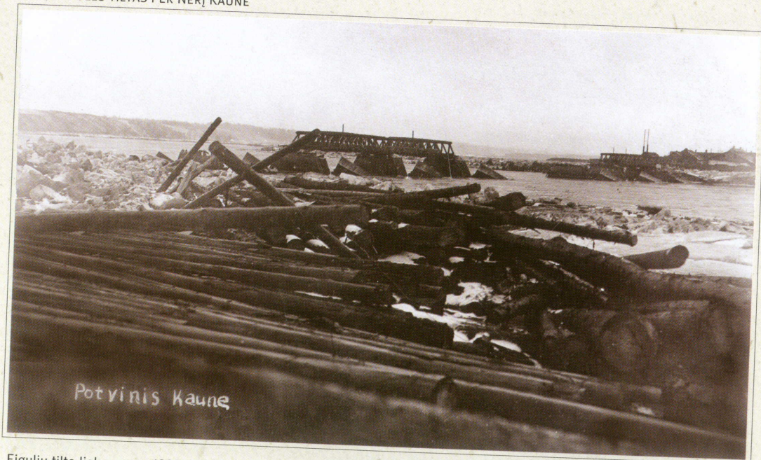
Eigulių tilto liekanos po 1926 m. potvynio prie nunešto Vilijampolės tilto liekanų.
