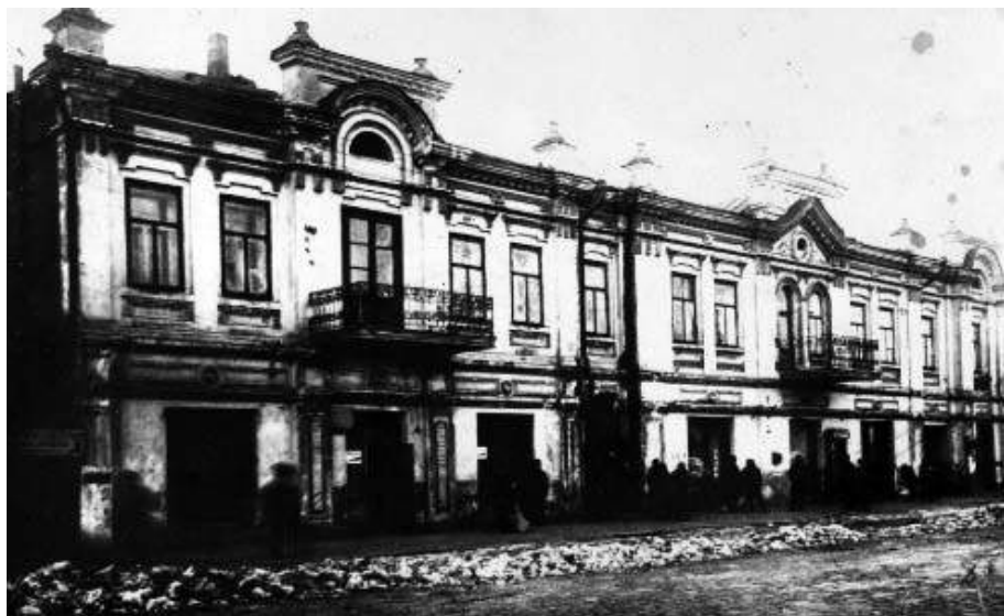
Дом Дунаева. Здесь располагался первый трибунал и следственная комиссия
