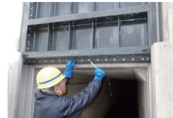
樋門ゲート点検
