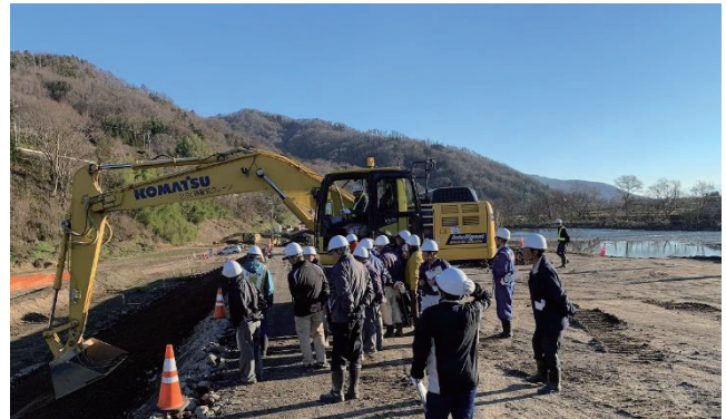
【小立野築堤工事現場見学会】
