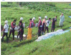
平成18年7月洪水 飯山市常盤での漏水対応 (月の輪工法)
