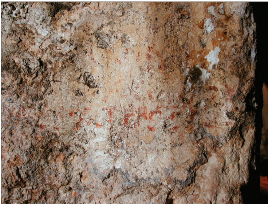
Fig. 85 - Basilica. Pilastro nord dell'arcata mediana destra con iscrizione rubricata
