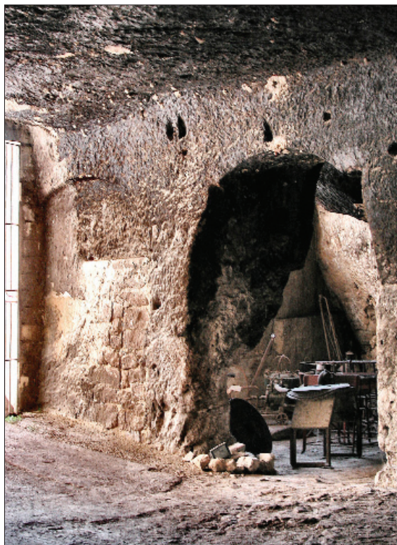
Fig. 80 - Basilica. Navata centrale: arcata cieca iniziale del fianco sinistro
