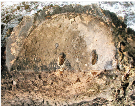
Fig. 122b - S. Marco (Noto). Volta a vela del battistero
