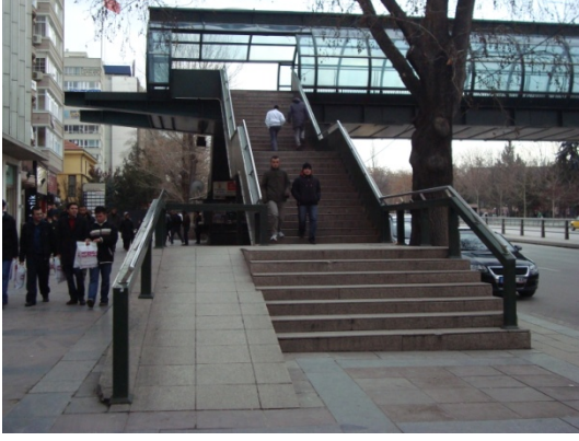
Şekil 4.46 Üst geçit ayağında fonksiyonu belirsiz, hiçbir yere ulaşmayan rampa
