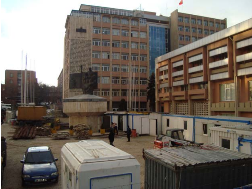
Şekil 4.39 Başöğretmen Atatürk Anıtı MEB Binası Atatürk Bulvarı Cephesi
