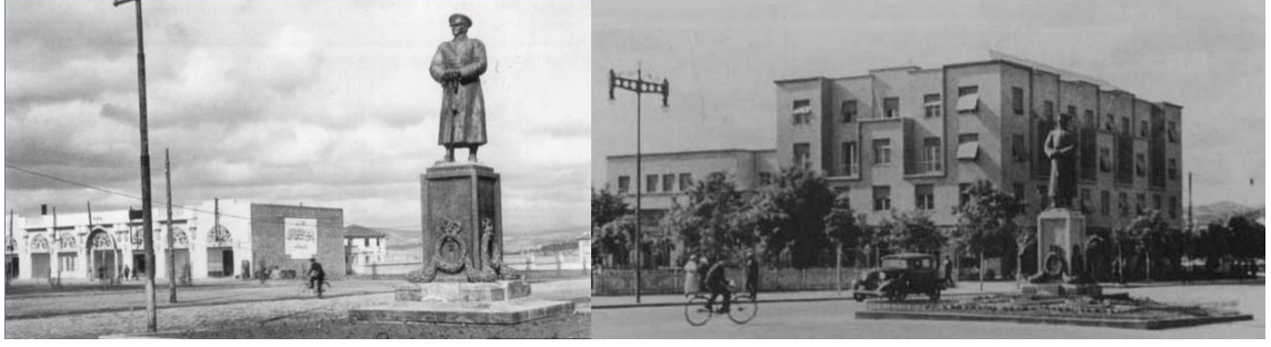
Şekil 4.23 Zafer Meydanı Sıhhiye Ordu Evi'nin yapımında öncesi ve sonrası (Anonim 2010b)
