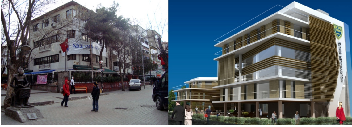
Şekil 4.20 Mülkiyeliler binaları varolan durumu ve tasarlanan yeni yapı (Anonim 2010d)
