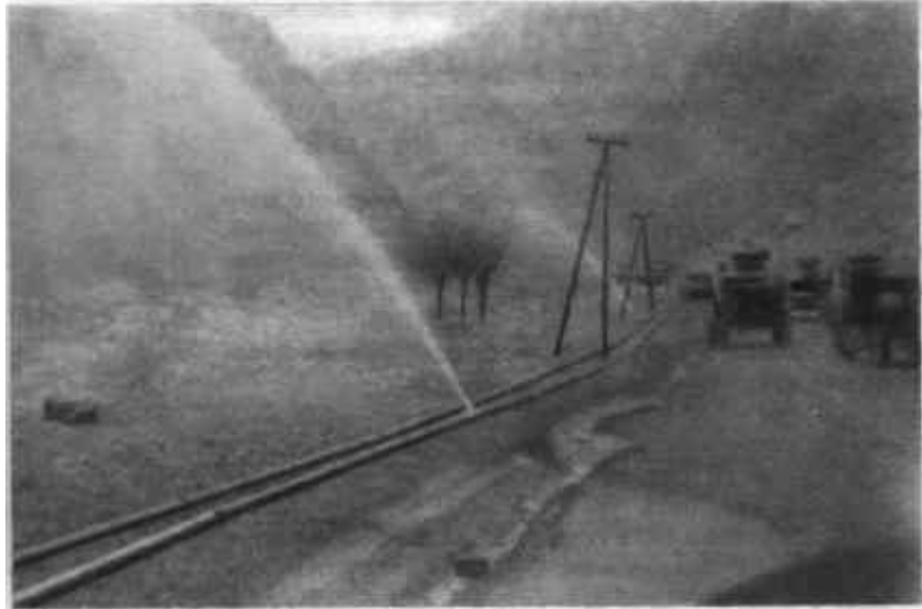
Пробитый трубопровод.
