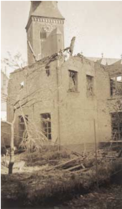
Zerstörter Gebäudekomplex von hinten. (288)
