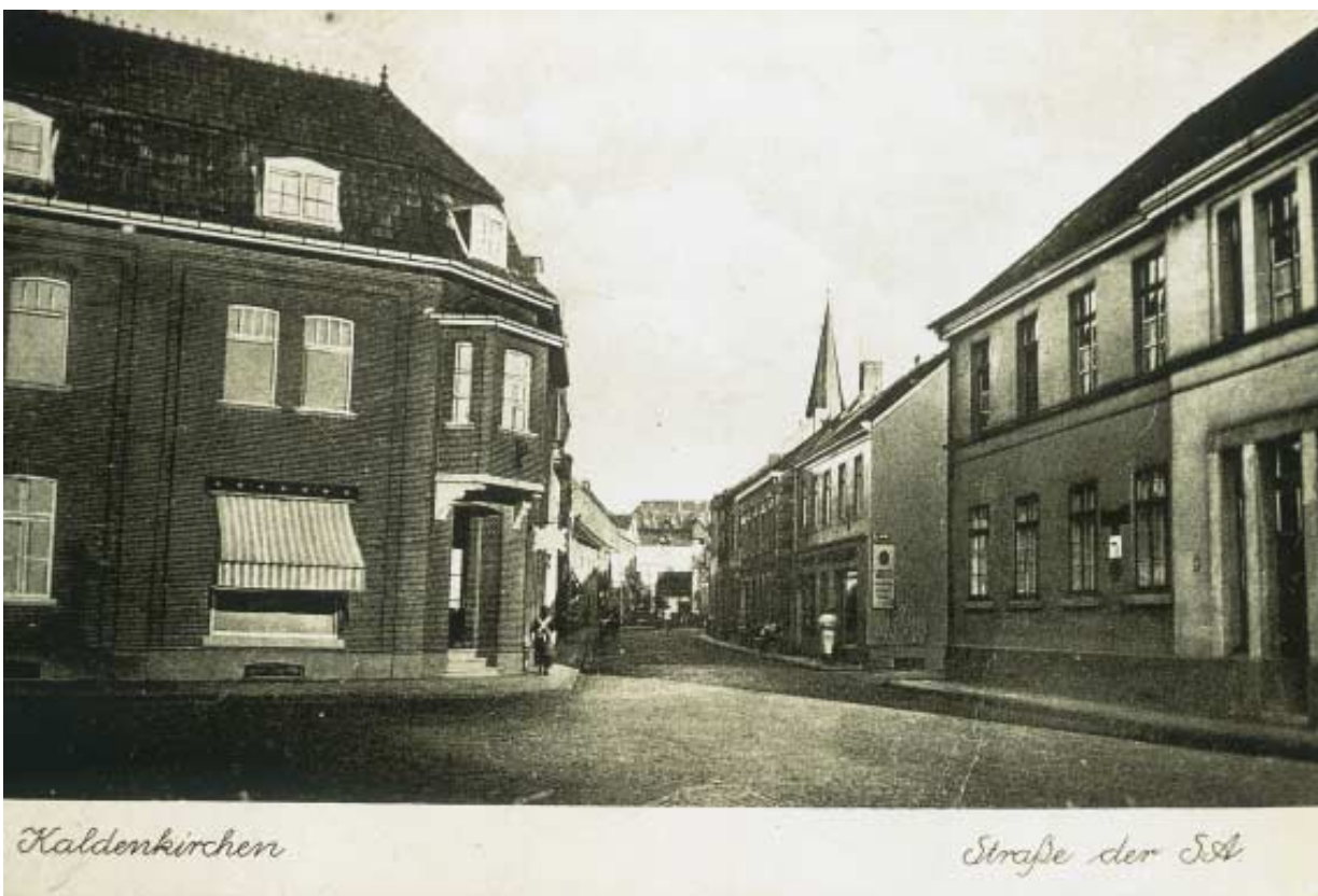
Links Eckhaus Beginen, Venloerstraße 2. (321)
