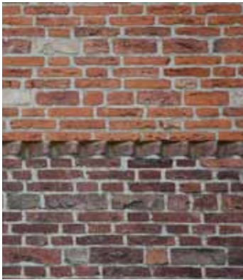
metselwerkfragment, Bergkerk (1952), Amersfoort
