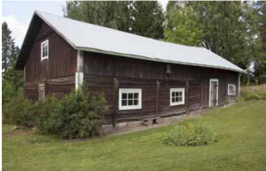
140B apolan hirsinavetta ja itäpäädyn lato. 140_B_apolan_navetta_ IMG_6477.jpg
