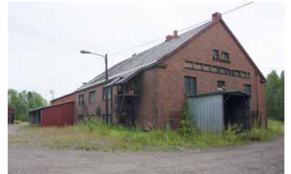
137C Jokelan Valun uudempi valimo ja pääty radalle. 137_C_Jokelan_Valu_valimo_IMG_6150.jpg
