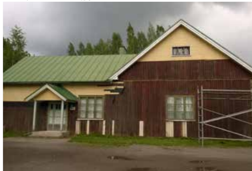
155 Linjala julkisivun uudelleenvuoraus paljasti alkuperäisen värityksen ja pystyvuorauksen _20150624_13_20_59_.jpg
