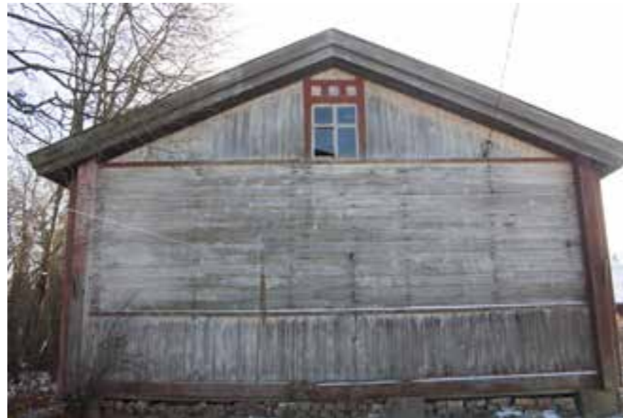
144A Lepänojan vanha päärakennus pohjoispäädystään ja judendikkuna ullakolla IMG_3303.jpg
