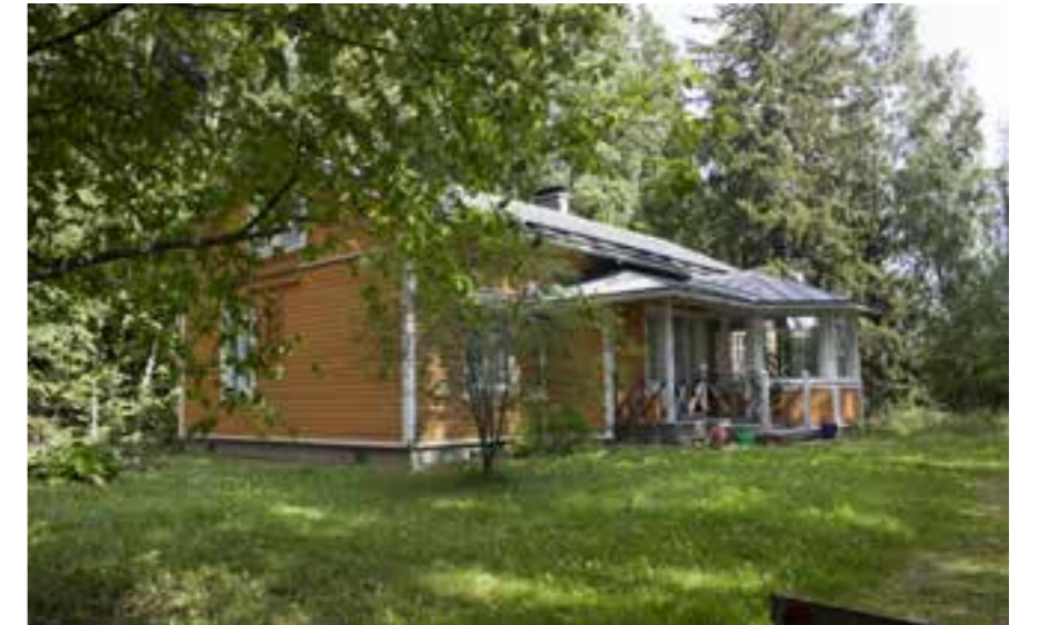
140C Suvannonmamman tupa joka on siirretty ja laajennettu. 140_C_suvannonmamman_tupa_siirretty_IMG_6451.jpg
