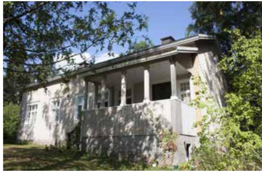
140 Apolan päärakennuksen avokuisti. 140_apola_IMG_6472.jpg
