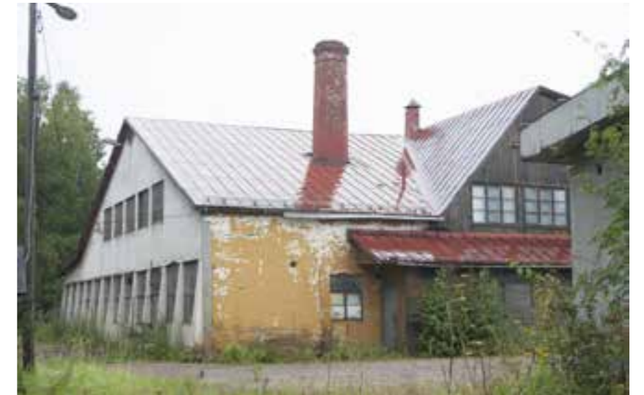
137B Jokelan Valun konttori eli Versta pohjoisen puolella tukirakenteineen. 137_B_Jokelan_Valu_konttori_IMG_6194.jpg
