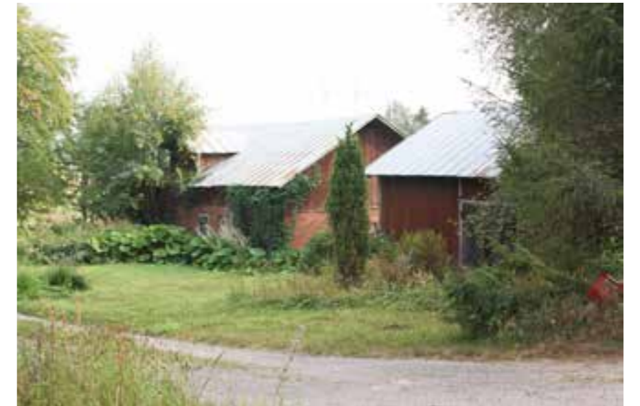
134A Junttilan tiilinavetta talleineen ja pihalato 134E pihaliittymästä kuvattuna IMG_1185.JPG
