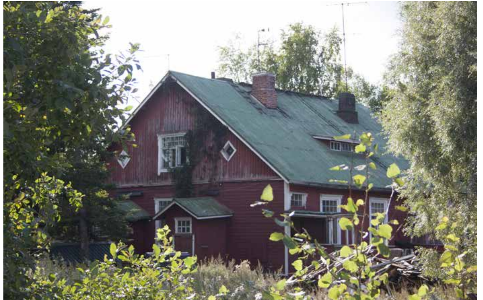
137E Jokelan valun tyovaenasunto Uutela tehtaan eteläpuolella. 137_E_jokelan_valun_tyovaenasunto_IMG_6521.jpg
