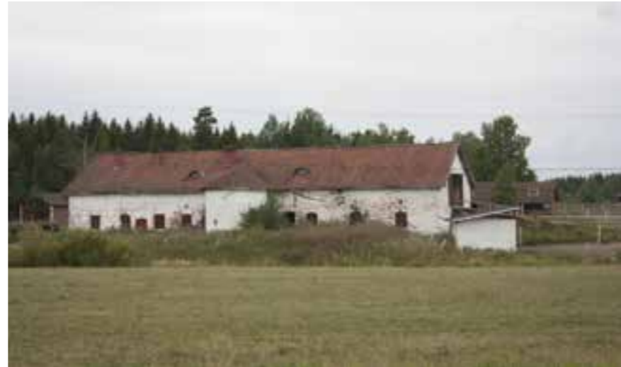
136A Rake Kallioistenmaan rapattu talli. 136_Rake_Kallioistenmaa_talli_IMG_6121.jpg
