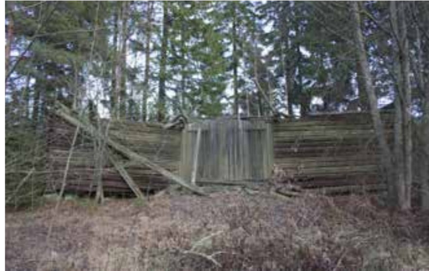
135D Lehmusvaaran pitkänurkkainen hirsilato odottaa kunnostusta tai uutta korvaavaa. 135_lehmusvaara_hirsilato_IMG_8453.jpg
