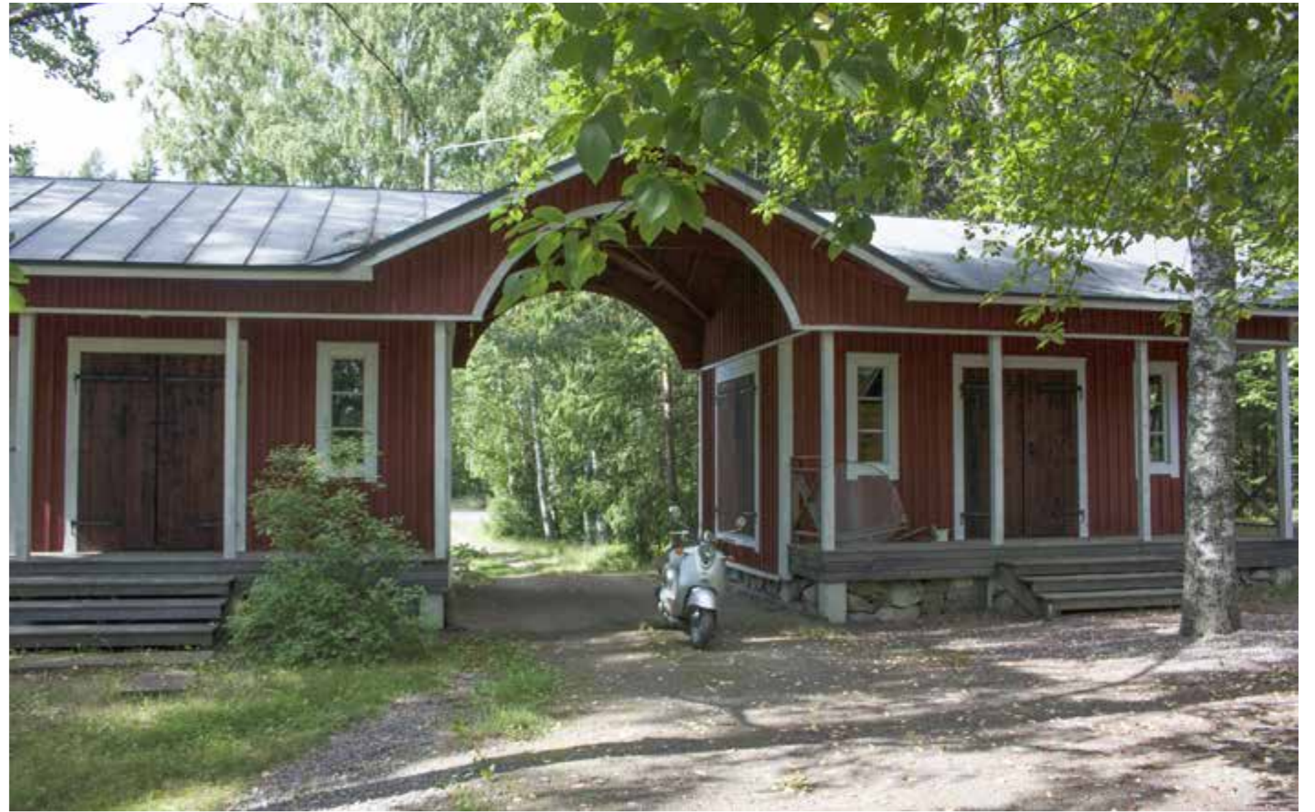
140D Suvannonmamman tuvan pihan porttirakennus. 140_D_porttirakennus_IMG_6452.jpg
