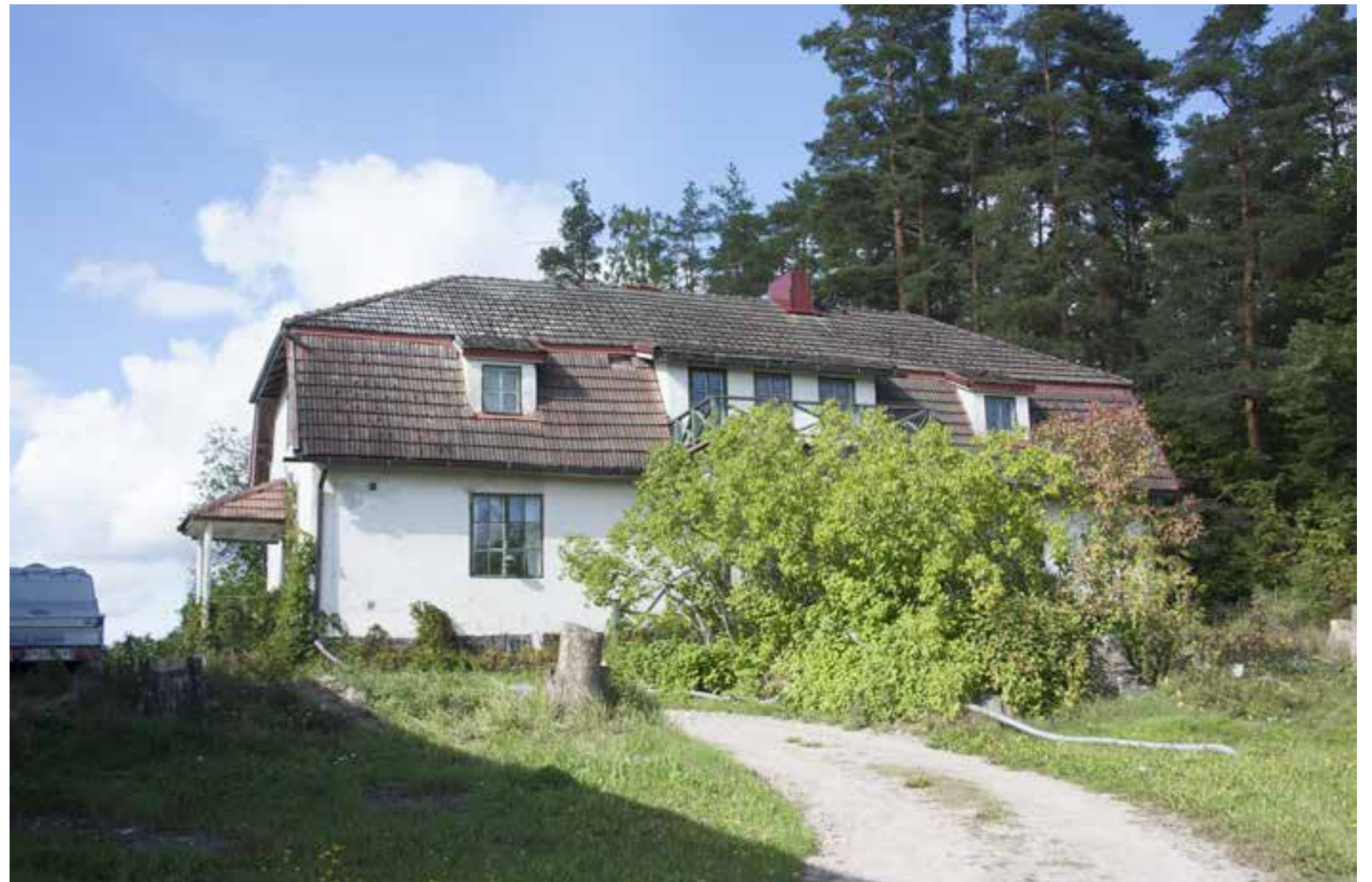
153 Jyskelän päärakennus 2011 ennen kunnostusta IMG_6565.jpg
