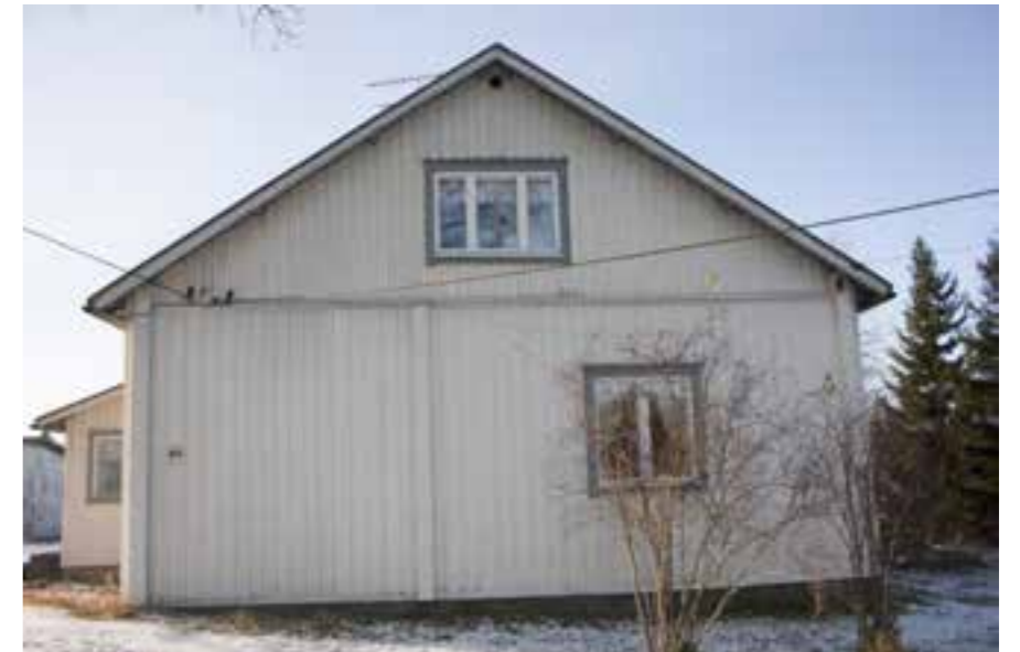
144 Lepänojan uusi päärakennus 2016 ja itäpäätty IMG_3310.jpg
