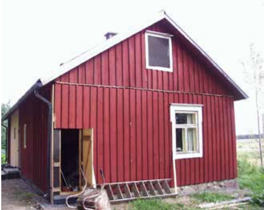
124 Rinteen asuinrakennus 2005 kunnostustyöt kesken PS PIC00023.jpg
