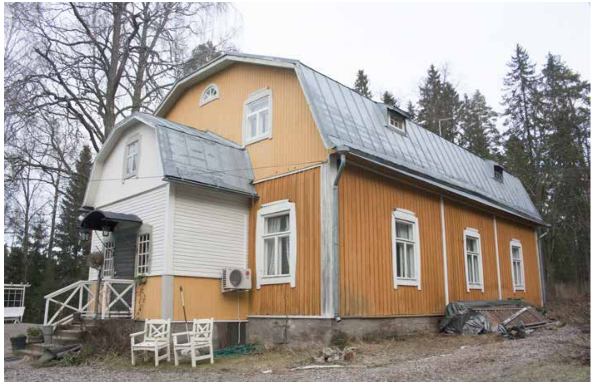
135 Lehmusvaaran päärakennus puutarhan puolelta kunnostettuna. 135_lehmusvaara_IMG_8467.jpg
