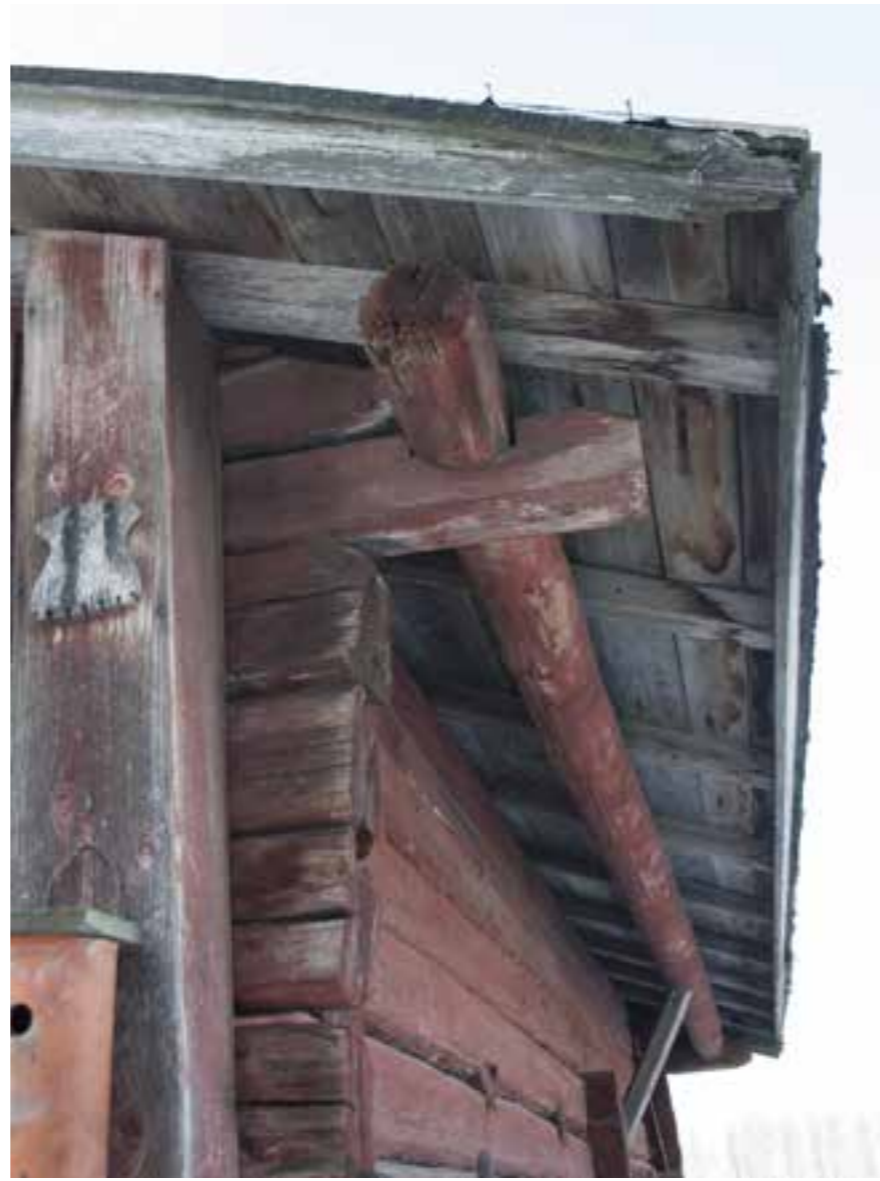
144B Lepänojan pariaitan päätykonsoli IMG_3307.jpg
