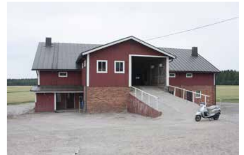
139A Hirvenojan punatiilinen ja puurakenteinen navetta.139_B_Hirvenojan_navetta_IMG_6147.jpg
