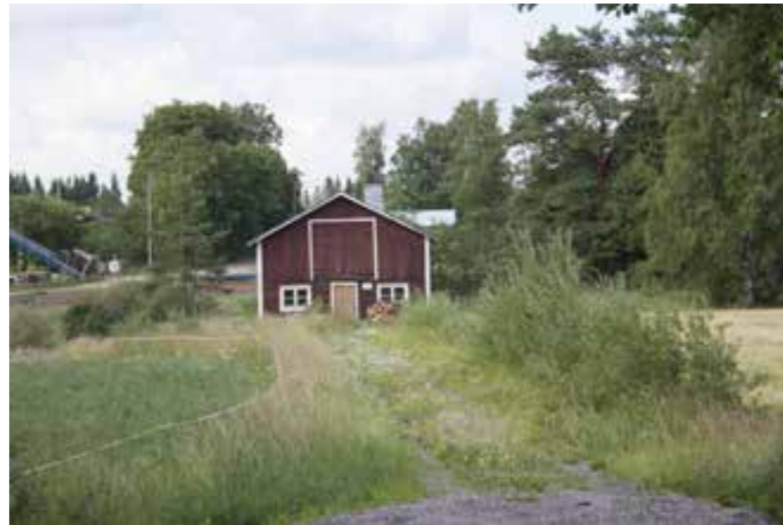
144 Lepänojan eteläpuolelta ja naapurin talousrakennus IMG_6091.jpg
