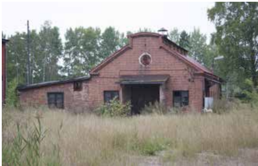
137D Jokelan Valun vanha valimo Toimela asuntopäättyineen ja sivusiipineen 137_D_Jokelan_Valu_valimo_IMG_6157.jpg
