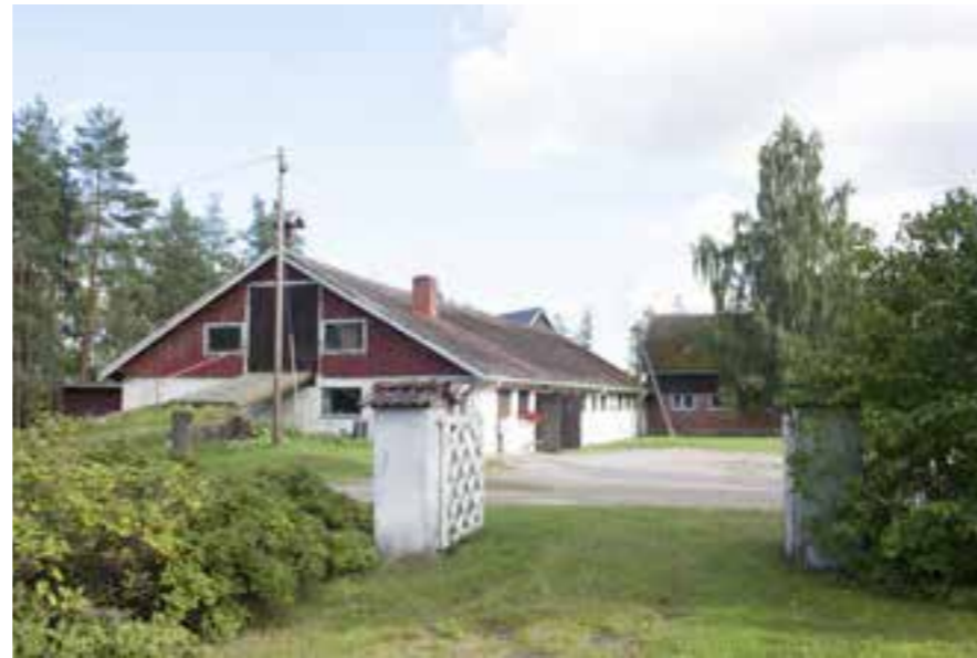
151 Malmarin päärakennuksen pääty. 151_D_Malmarin_navetta_E_talli_IMG_6586.jpg
