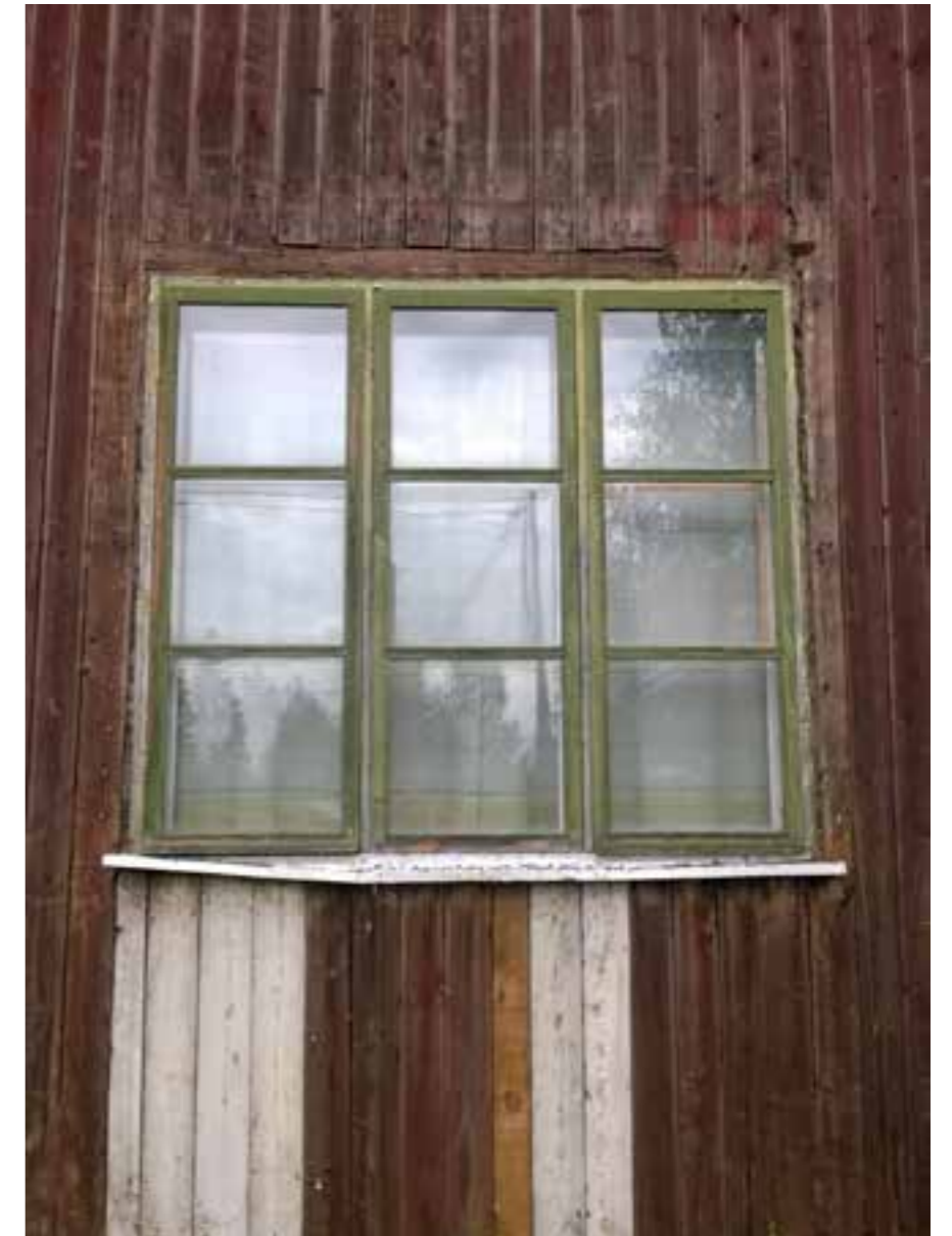
155 Linjala nurkkalaudoilla paikattua seinää_20150624_13_22_12_Smart-Shoot.jpg
