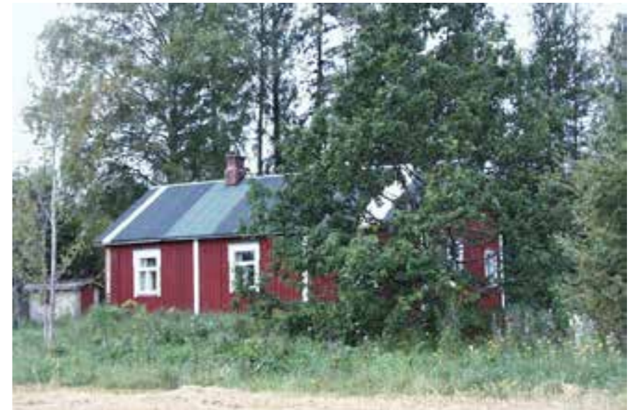
124 Rinteen asuinrakennus 2005 kesken kunnostuksen PS PIC00026.jpg
