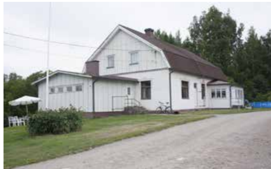
139 Hirvenojan päärakennus jatkeineen pihanpuolelta. 139_hirvenoja_IMG_6146.jpg
