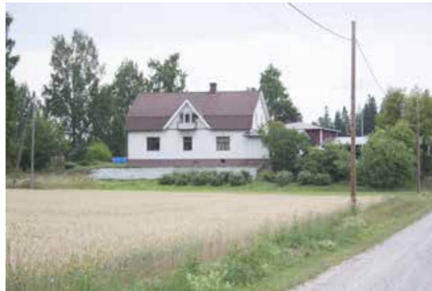
139 Hirvenojan päärakennus pihatieltä.139_Hirvenoja_IMG_6145.jpg
