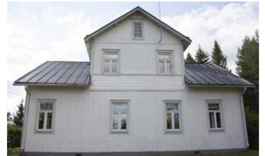
141 Ainolan päärakennus etelästä. 141_ainola_IMG_6510.jpg
