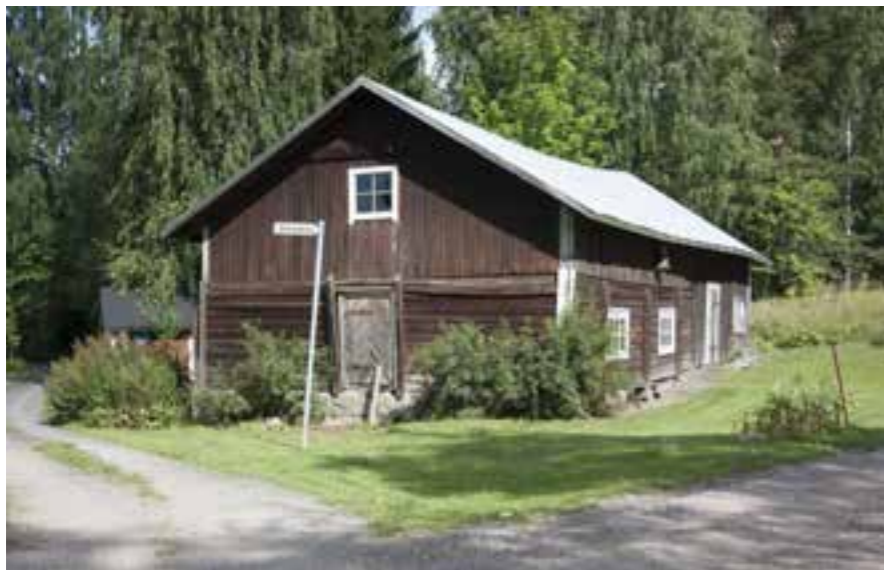
140B Apolan lyhynurkkainen hirsinavetta tienristeyksessä. 140_B_apolan_ navetta_IMG_6461.jpg
