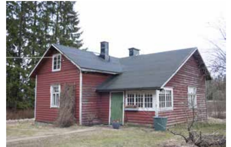
147 Kerttulan päärakennus ja kuisti IMG_6695.jpg
