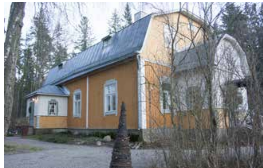
135 Lehmusvaaran päärakennus sisäänkäynnin puolelta kunnostettuna. 135_lehmusvaara_IMG_8475.jpg
