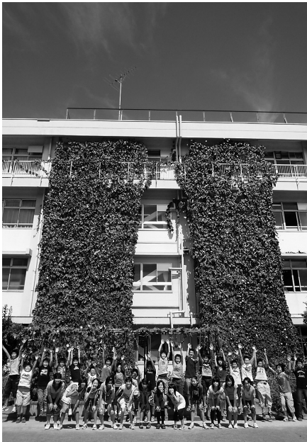
板橋区立高島第五小学校
