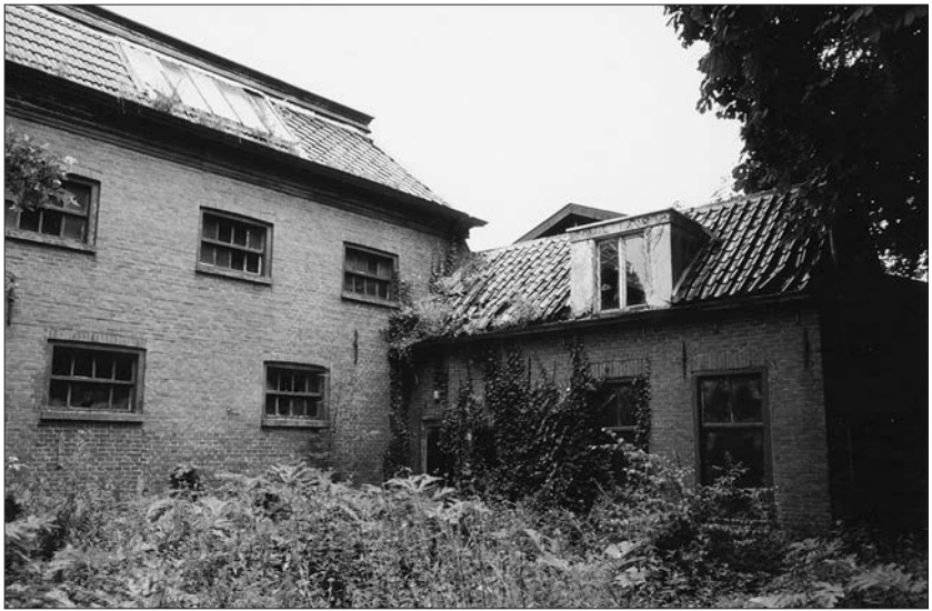
Afb. 35. Hilghepad 3-5, overzicht van het complex. Foto: Jaap Buist
