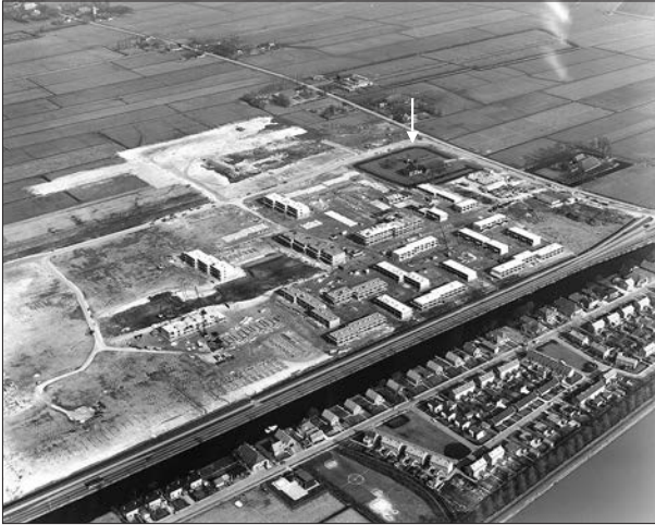
Afb. 25. Lewenborg, een woonwijk in aanbouw in 1972. De pijl geeft aan waar Noorddijkerweg 31 zich bevindt. Foto: Aerophoto Eelde.
