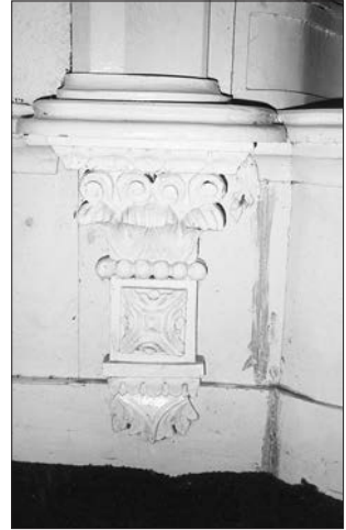
Afb. 26. Noorddijkerweg 31, console onder een vensterbank in de voorkamer. Foto: Henk Wierts.
