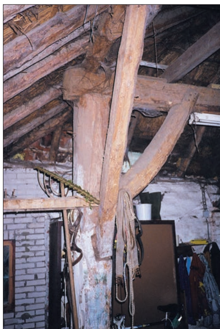
Afb. 9. Euvelgunnerweg 37, detail van een gebint in de schuur. Foto: Jan van der Hoeve.
