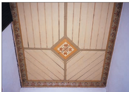
Afb. 5. Euvelgunnerweg 27, plafond van kraaldelen met schildering in de gang. Foto: Aletta Bastmeijer.
