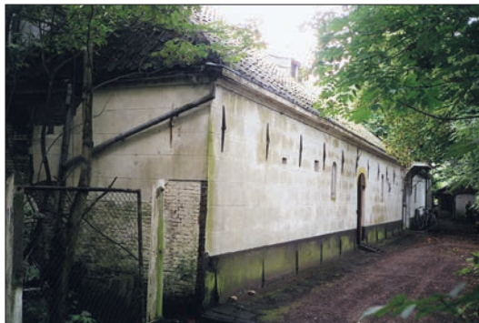
Afb. 14. Van Heemskerckstraat 97, het pakhuis met de woning gezien naar het westen. De ankers markeren de vloerniveaus. Foto: Jan van der Hoeve.
