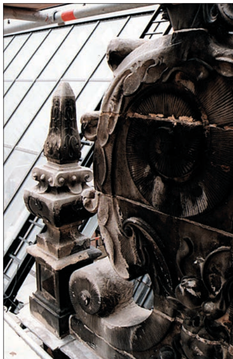
Afb. 7: Goudkantoor. Klauwstuk van de oostgevel vóór restauratie. Foto: L. Muller, Zuidhorn.
