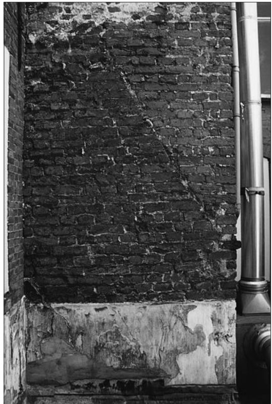
Afb. 22: Gelkingestraat 52. Detail van de achtergevel van het voorhuis met daarin opgenomen zijn lagere Middeleeuwse voorganger. Foto: Jan van der Hoeve, Utrecht.
