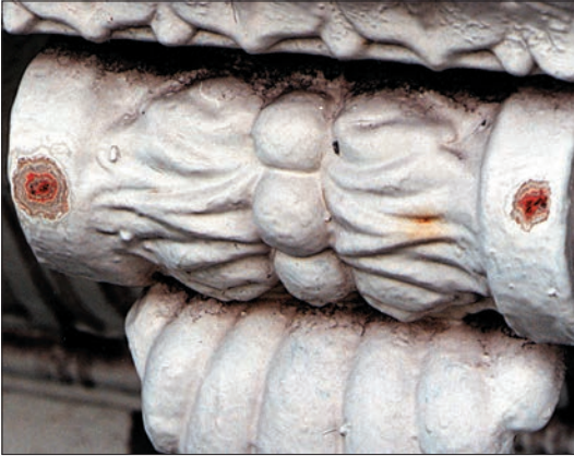
Afb. 1: Korenbeurs, gietijzeren console met links en rechts door schuren aan het oppervlak gebrachte verflagen. Foto: L. Muller, Zuidhorn.
