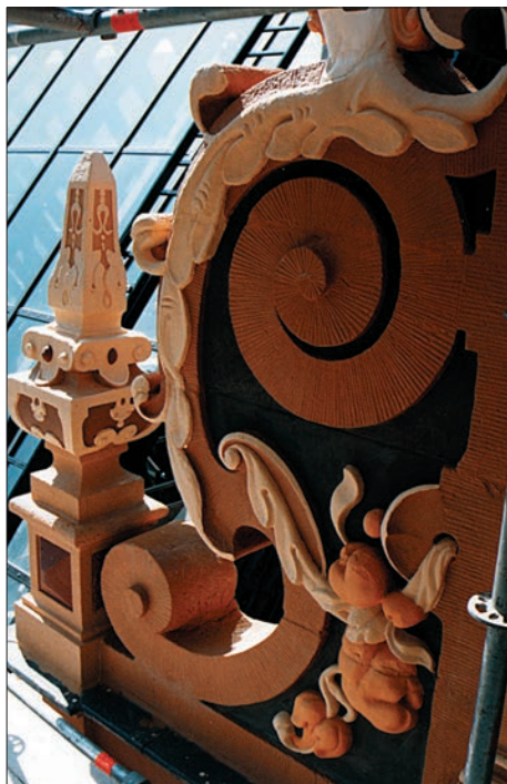
Afb. 8: Goudkantoor. Klauwstuk van de oostgevel na restauratie. Foto: L. Muller, Zuidhorn.
