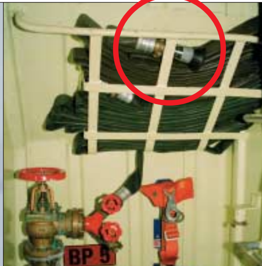
Släckmunstycke Fog-Jet finns utplacerat vid varje brandpost; förbrukning 230 l/min.
