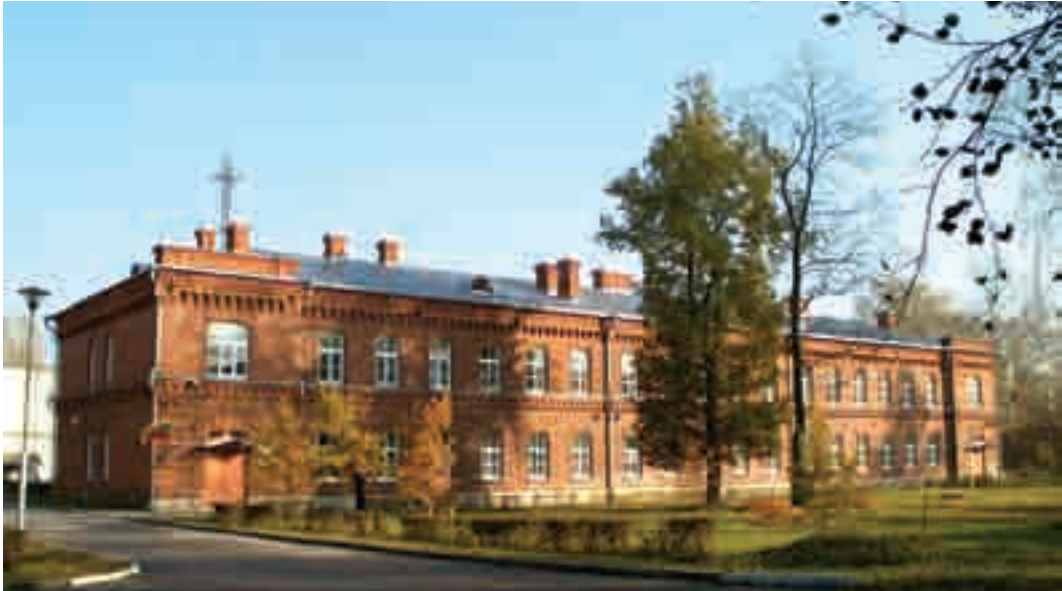
Oro erdvės stebėjimo ir kontrolės valdybos pastatas Kaune
