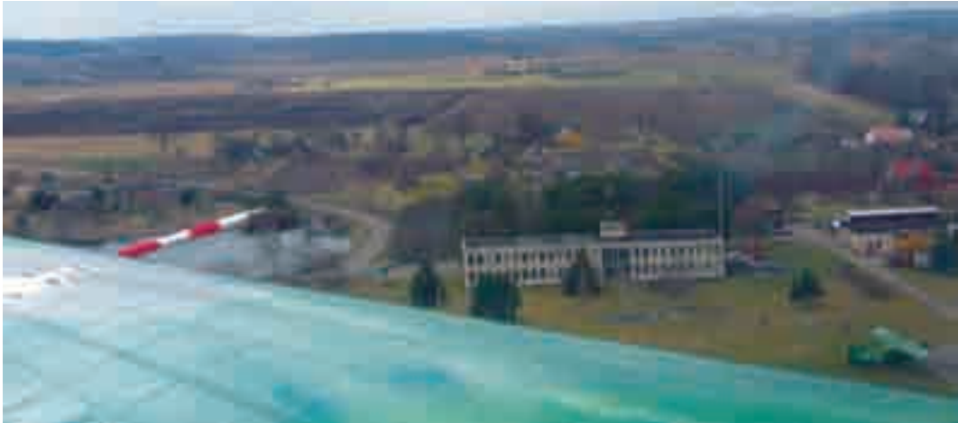
KASP Aviacijos eskadrilės administracinis pastatas Kyviškėse. 2005 m.
