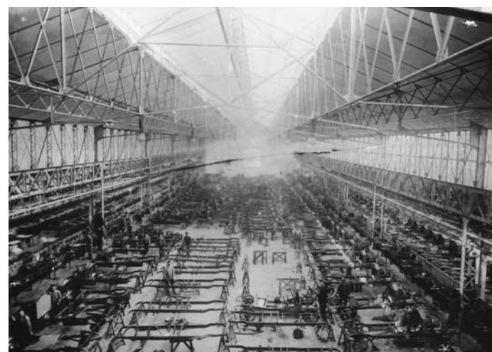
1909 > Atelier de montage châssis
