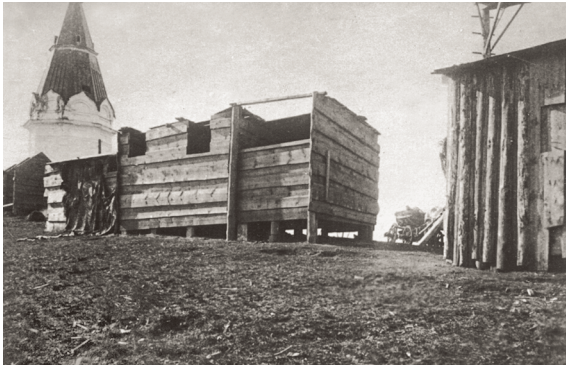
Красноярск. Строения для наблюдений солнечного затмения (фото А.С.Попова)
