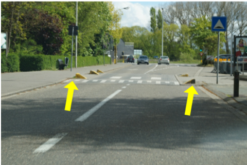
Versmalling langs beide zijde met berm betonblokken gele vlag langs beide zijden
