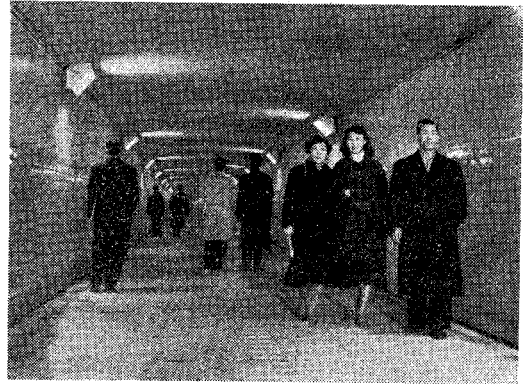
写真—5 海底人道（幅員 3.8 m、高さ 2.5 m）
