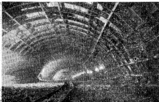
写真-2 陸上部 315m 区間の鉄製アーチ支保工
