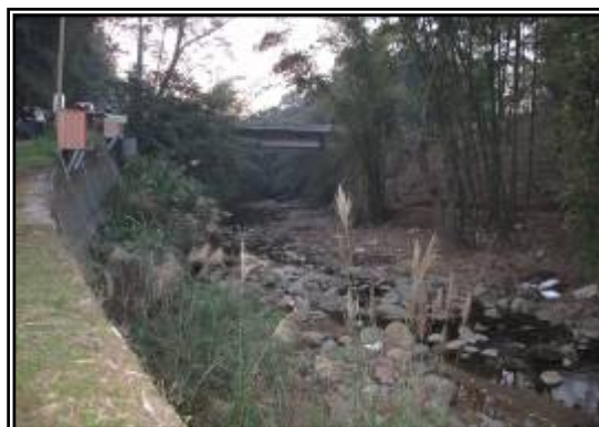
A. 東豐橋上游和勳橋
