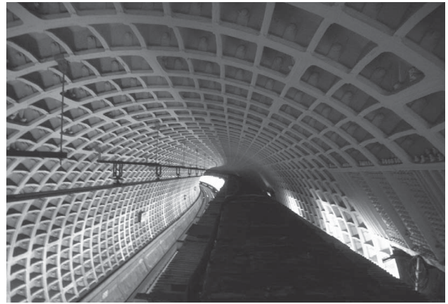
写真-5 防錆工完了
