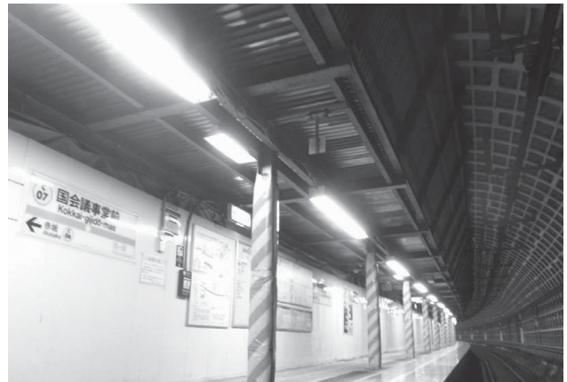
写真-6 構内防護設置状況
