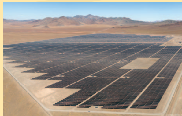
141 MW, Luz del Norte Solar Plant. Atacama Desert, Chile.
