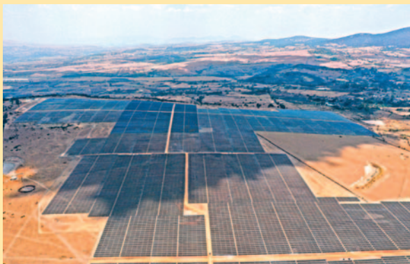
129 MW, Guajiro Solar Plant. Hidalgo, Mexico.
