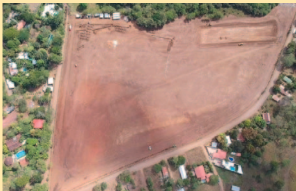
7.24 MW, Hacuacas Solar Plant. Costa Rica.
