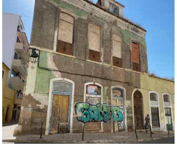
Casa "Porta da Serra" to be renovated
