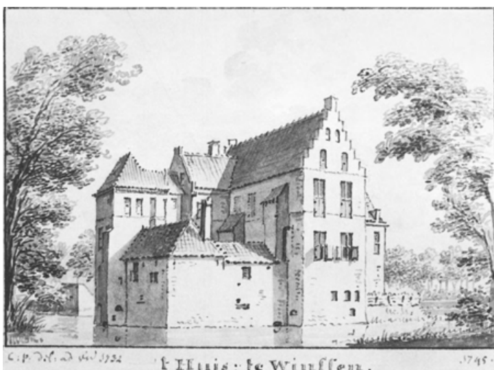
Afb. 160. Het Huis te Winssen gezien vanuit het zuidwesten, door C. Pronk. N.M.C., Nijmegen.
