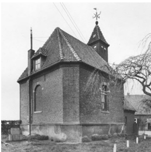
Afb. 283. Hervormde kerk. Het kerkgebouw in zijn huidige gedaante (opn. 1968).
