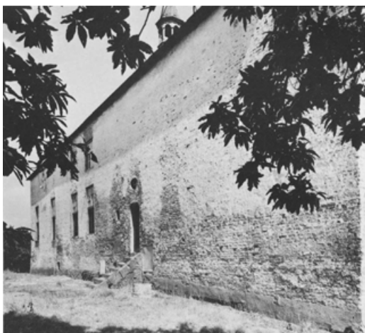
Afb. 114. Huis Doddendaal. De westgevel van het hoofdblok (opn. 1974).
