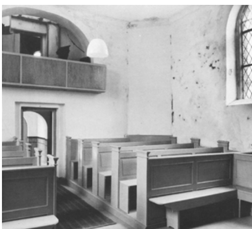
Afb. 287. Hervormde kerk. De banken in het nog intacte interieur (opn. 1968).
