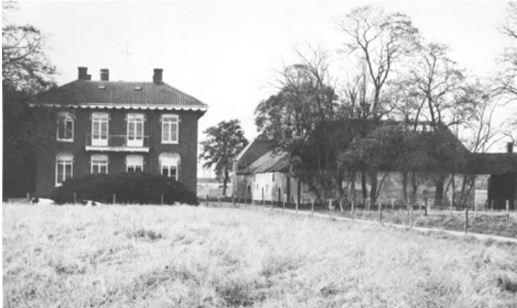
Afb. 240. Rijksstraatweg nr. 232. Villa 'Bergzicht' en de gebouwen van het brouwerijcomplex (opn. 1977).
