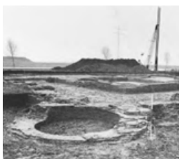
Afb. 222. De fundering van de noordoostelijke toren van de hoofdburcht (opn. 1980).
