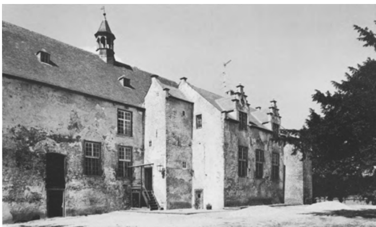
Afb. 108. Huis Doddendaal. Het 14de-eeuwse hoofdblok met de 15de-eeuwse uitbreiding en de nog iets jongere traptoren gezien vanuit het zuidoosten. Opname tijdens de restauratie, 1974.
