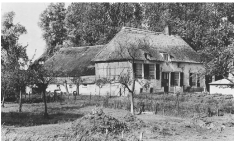
Afb. 130. Binnenweg nr. 5. Boerderij-herberg 'De Clef' gezien vanaf de Van Heemstraweg, voor de restauratie (opn. 1967).
