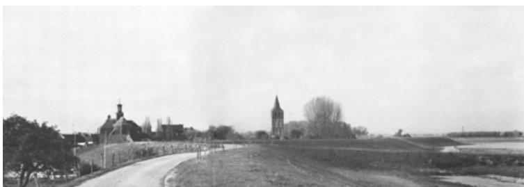
Afb. 143. De middeleeuwse toren en de in 1938 gebouwde R.K. kerk gezien vanuit het oosten vanaf de Waalbandijk (opn. 1981).
