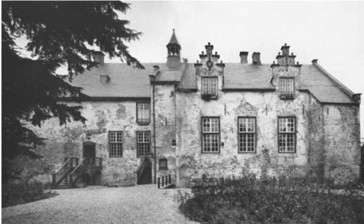
Afb. III. Huis Doddendaal. Overzicht van de oostgevel naar opname uit 1981. Zie blz. 102-103.
