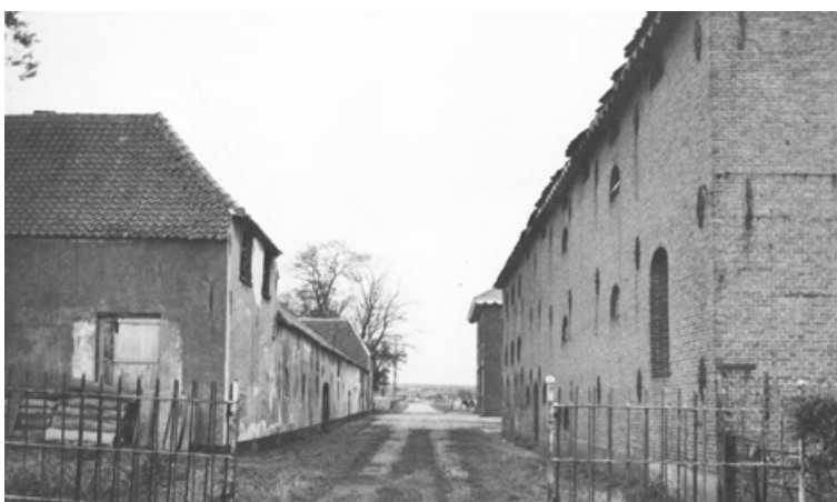
Afb. 242. Het brouwerijcomplex gezien vanuit het westen (opn. 1977).
