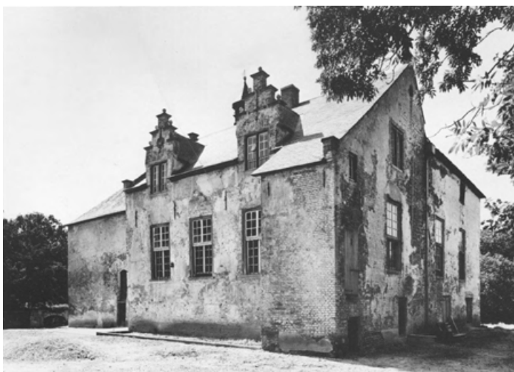
Afb. 110. Huis Doddendaal. De oost- en noordgevel van het hoofdblok en de 15de-eeuwse uitbreiding (opn. 1974).
