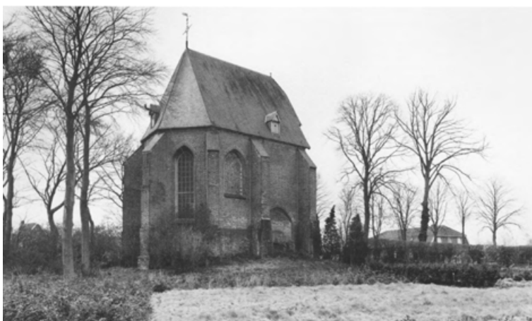
Afb. 301. Hervormde kerk. Het koor van de kerk gezien vanuit het noordoosten (opn. 1978).
