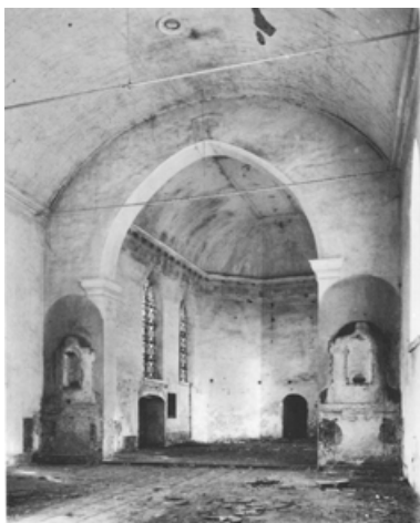
Afb. 72. R.K. kerk. Interieuroopname uit 1918 van het middeleeuwse koor dat in 1831 inwendig werd verlaagd door het aanbrengen van een stucplafond (opn. 1918).
