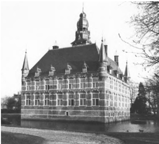
Afb. 452. Het Kasteel-Raadhuis vanuit het kasteelpark aan de westzijde (opn. 1977).
