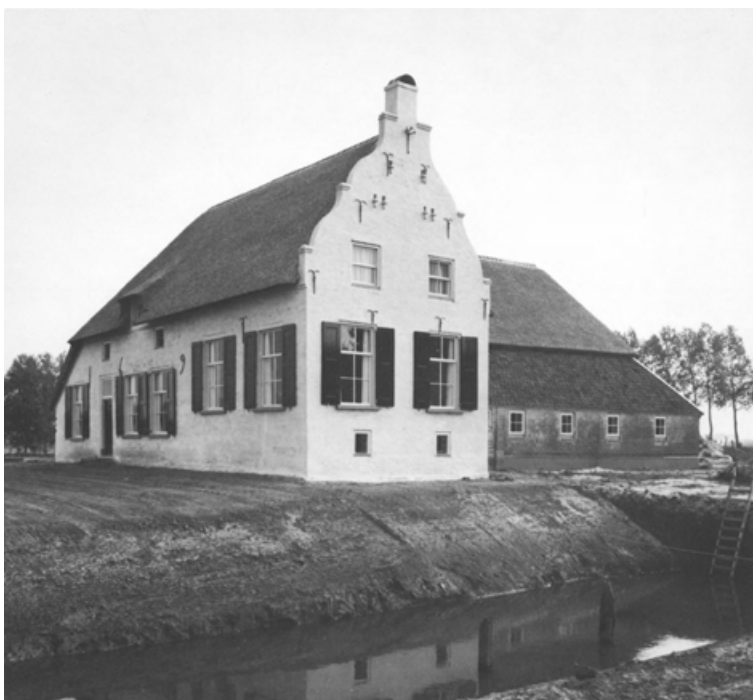
Afb. 167. Leegstraat 41. 'Brouwershofstad', na de restauratie (opn. 1979).
