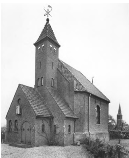
Afb. 285. De Hervormde kerk met de torenaanbouw en het portaal uit 1934 (opn. 1968).
