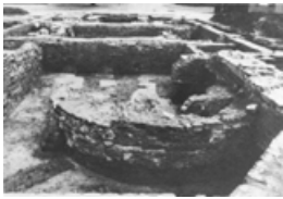
Afb. 249. R.K. kerk. Opgravingen 1961. Overzicht vanaf de koorsluitingen in westelijke richting. Foto R.O.B., Amersfoort.
