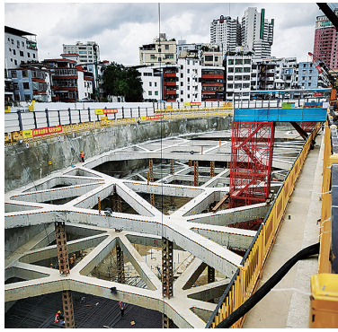
建设中的粤宝路蓄水池。
